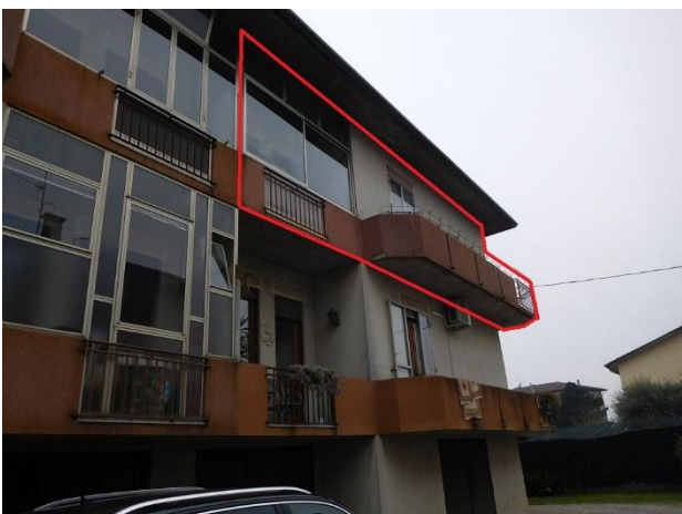
Foto 5 – vista da nord – particolare appartamento
