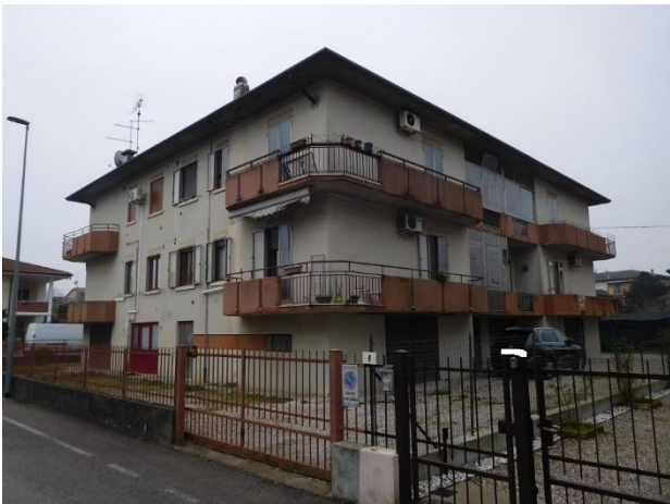
Foto 3 – vista da nord-est – da via Brescia
