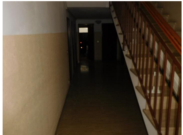
Foto 34 – piano terra – accesso comune ai garage
