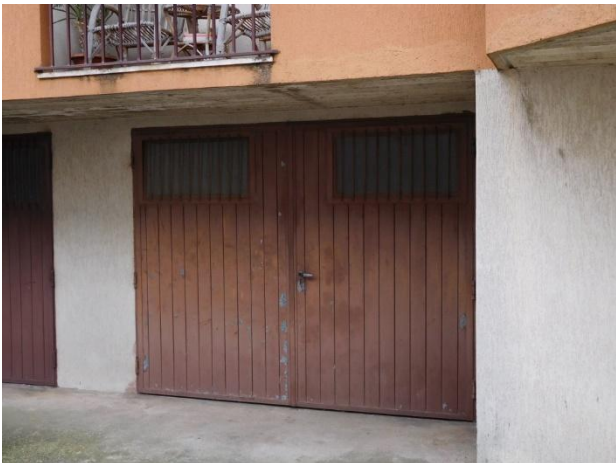
Foto 33 – vista da nord – accesso garage
