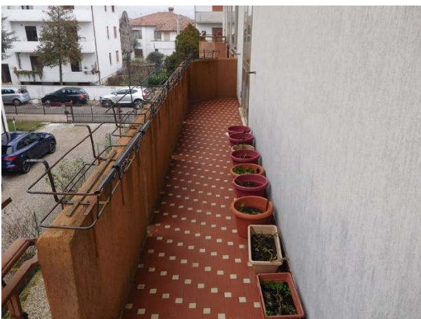
Foto 23 – piano secondo – appartamento – terrazza
