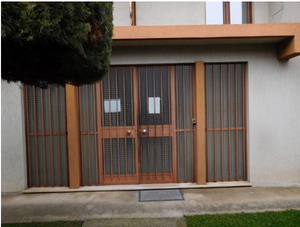
Foto 7 – vista da sud – particolare ingresso comune
