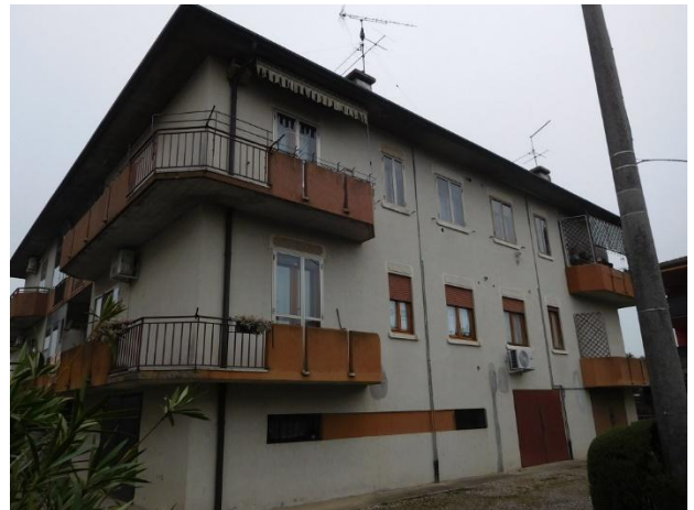
Foto 4 – vista da nord-ovest
