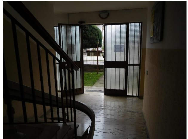
Foto 8 – vista ingresso comune piano terra
