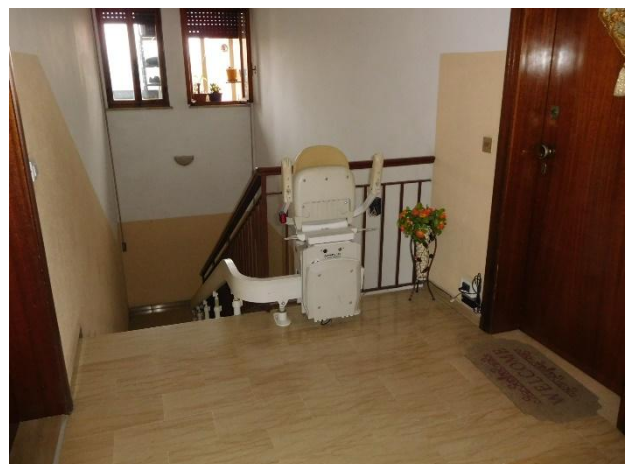
Foto 12 – vista vano scale comune
