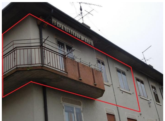
Foto 6 – vista da sud-est – particolare appartamento
