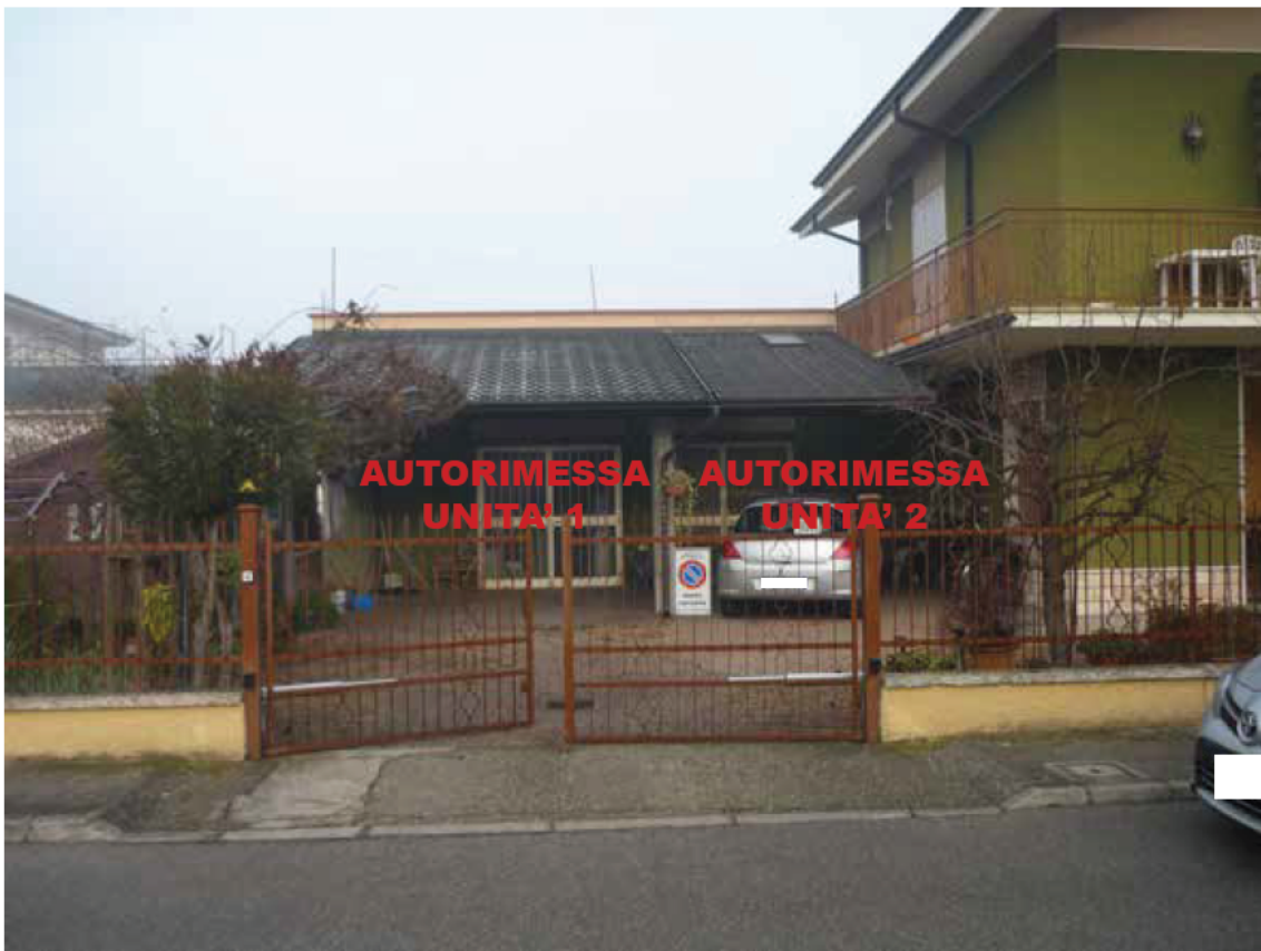
foto 07 - vista esterna autorimesse
