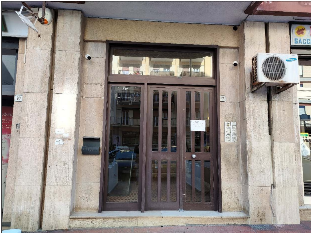
Portone di ingresso dell'edificio
