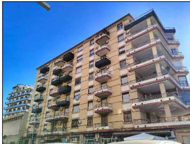
Edificio di via Armando Diaz n. 92
