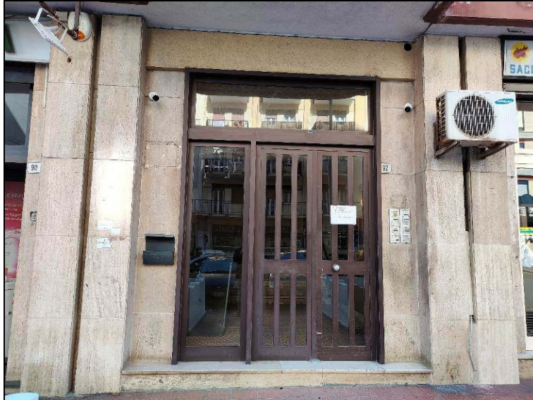
Portone di ingresso dell'edificio
