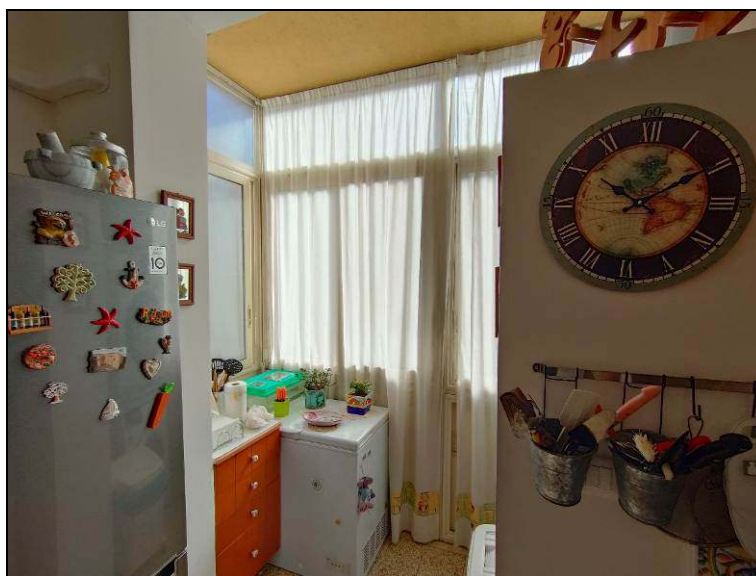
Veranda realizzata sul balcone posto in corrispondenza del retrospetto, con rimozione di infisso
