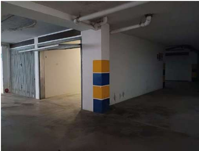
FOTO 23 – Box auto, vista dalla corsia di manovra
