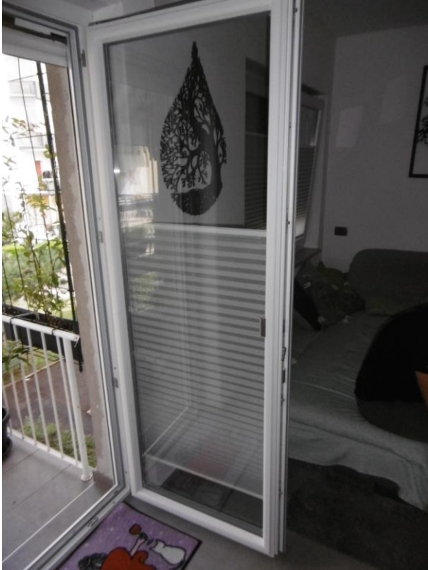
Interno – Alloggio - Portafinestra
