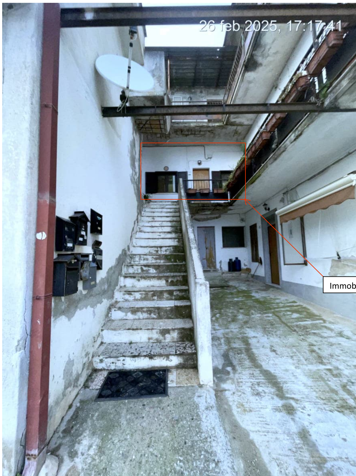
Foto 1 - Esterno lato Ingresso
