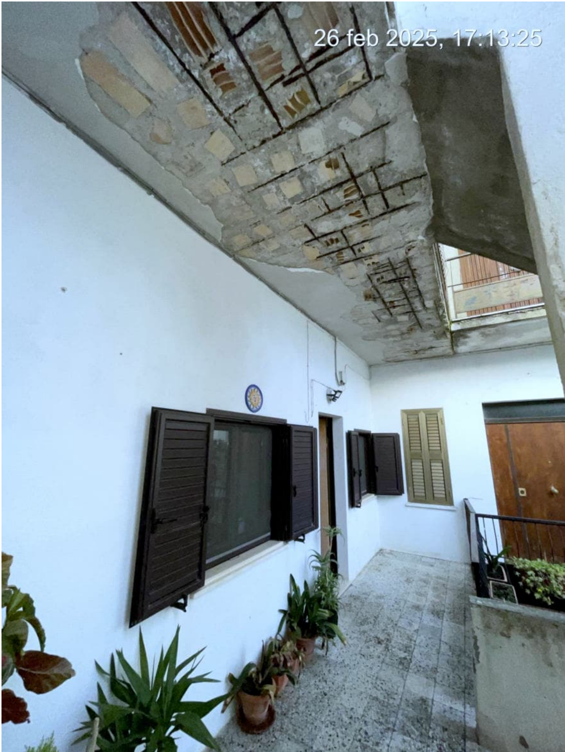
Foto 2 – Esterno Ingresso Piano Primo
