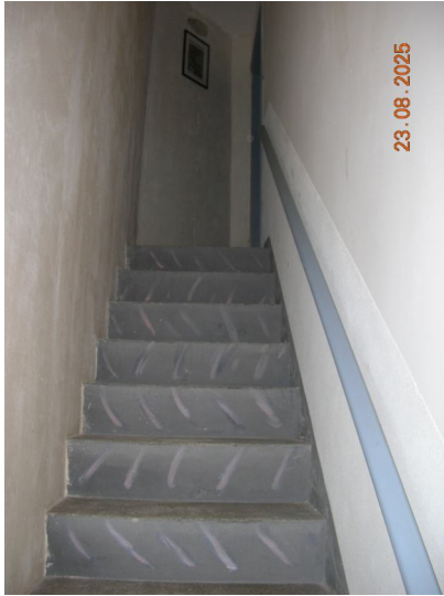
19-Scalinata per piano primo
