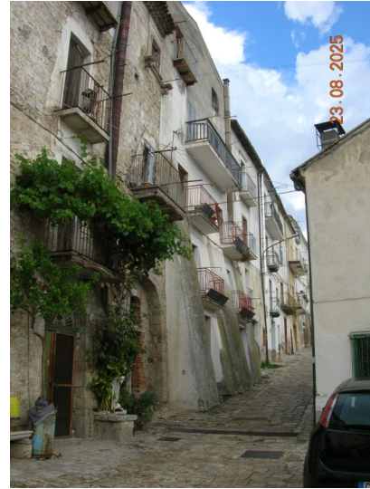
02-Esterni del cespite
