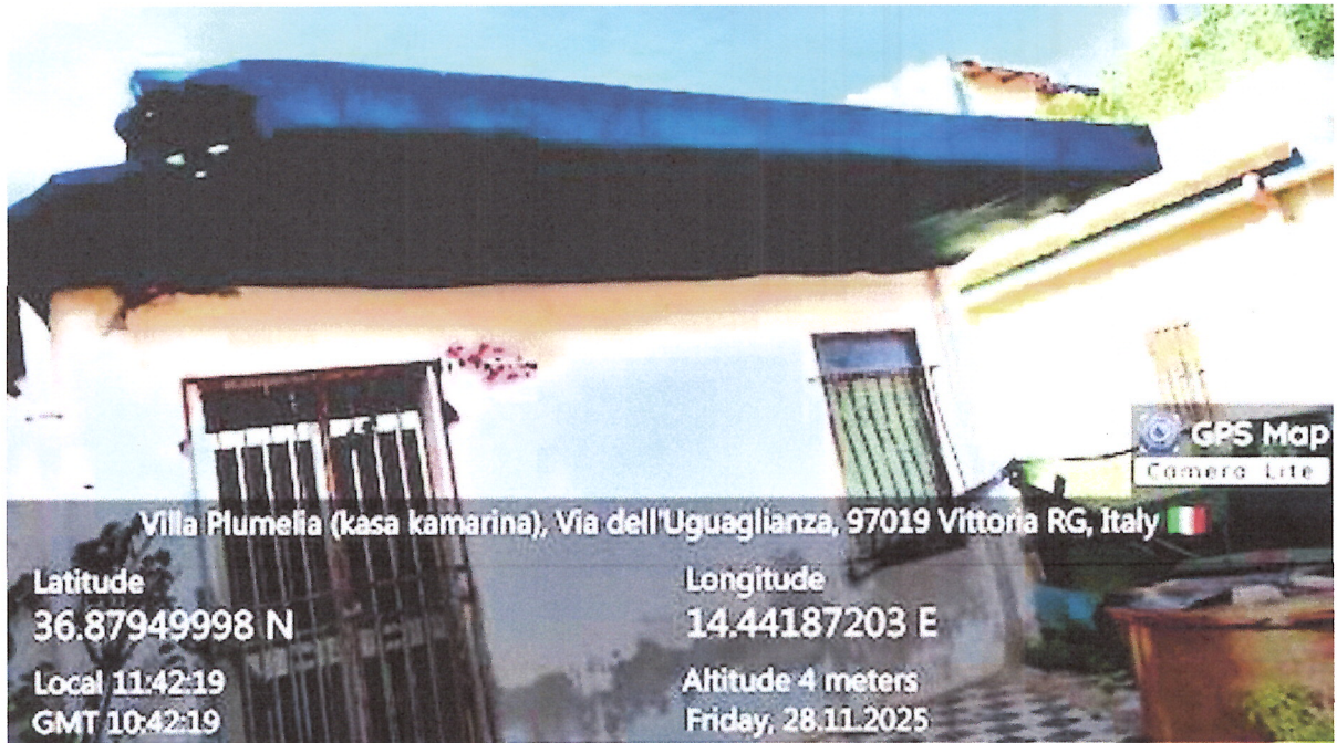
Foto 16 Messa in sicurezza fabbricato a piano terra Vittoria Foglio 190 particella 870 sub 1
