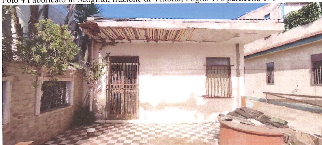
Foto 5 Appartamento piano terra Vittoria Foglio 190 particella 870 sub 1 – vista esterni
