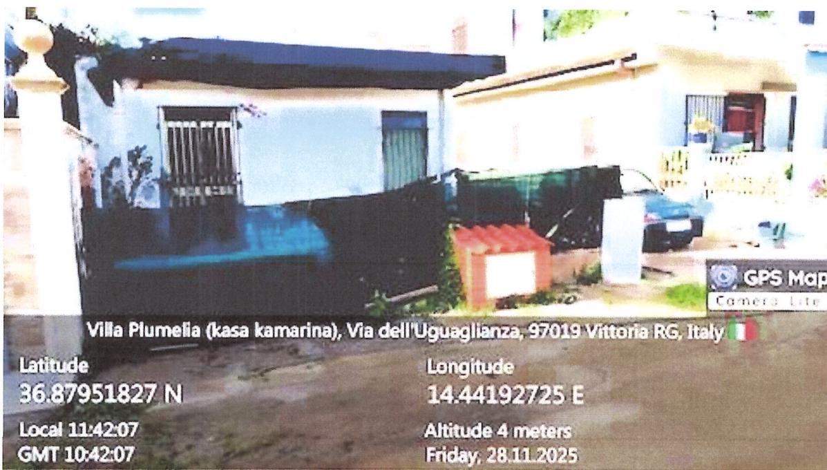
Foto 15 Messa in sicurezza fabbricato a piano terra Vittoria Foglio 190 particella 870 sub 1
