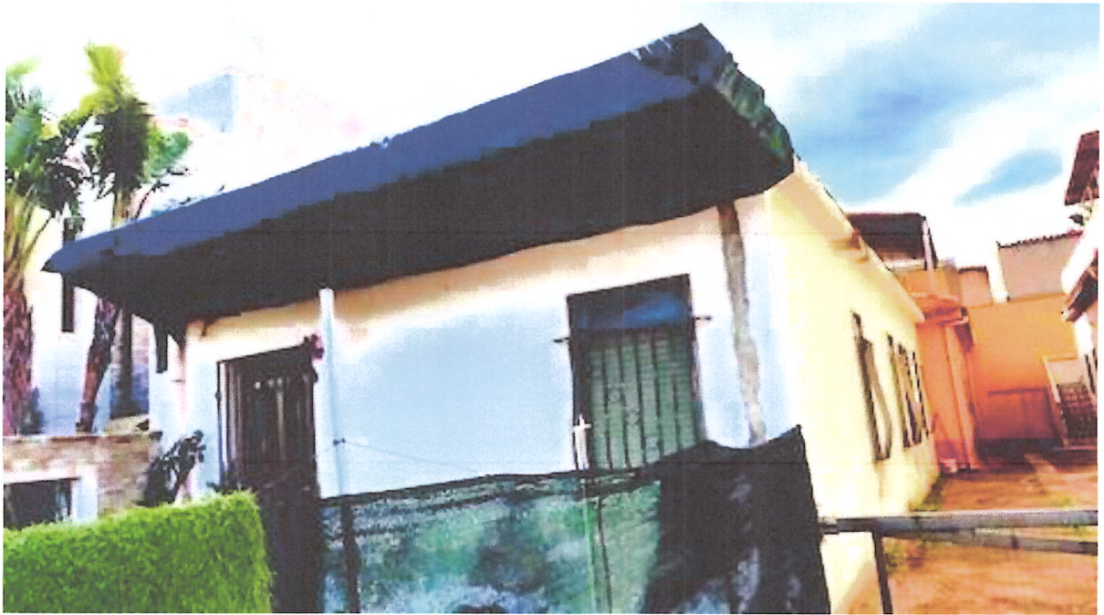
Foto 18 Messa in sicurezza fabbricato a piano terra Vittoria Foglio 190 particella 870 sub 1
