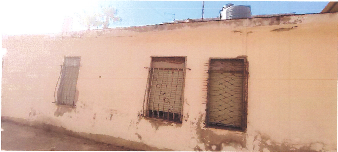
Foto 7 Appartamento piano terra Vittoria Foglio 190 particella 870 sub 1 – vista esterni
