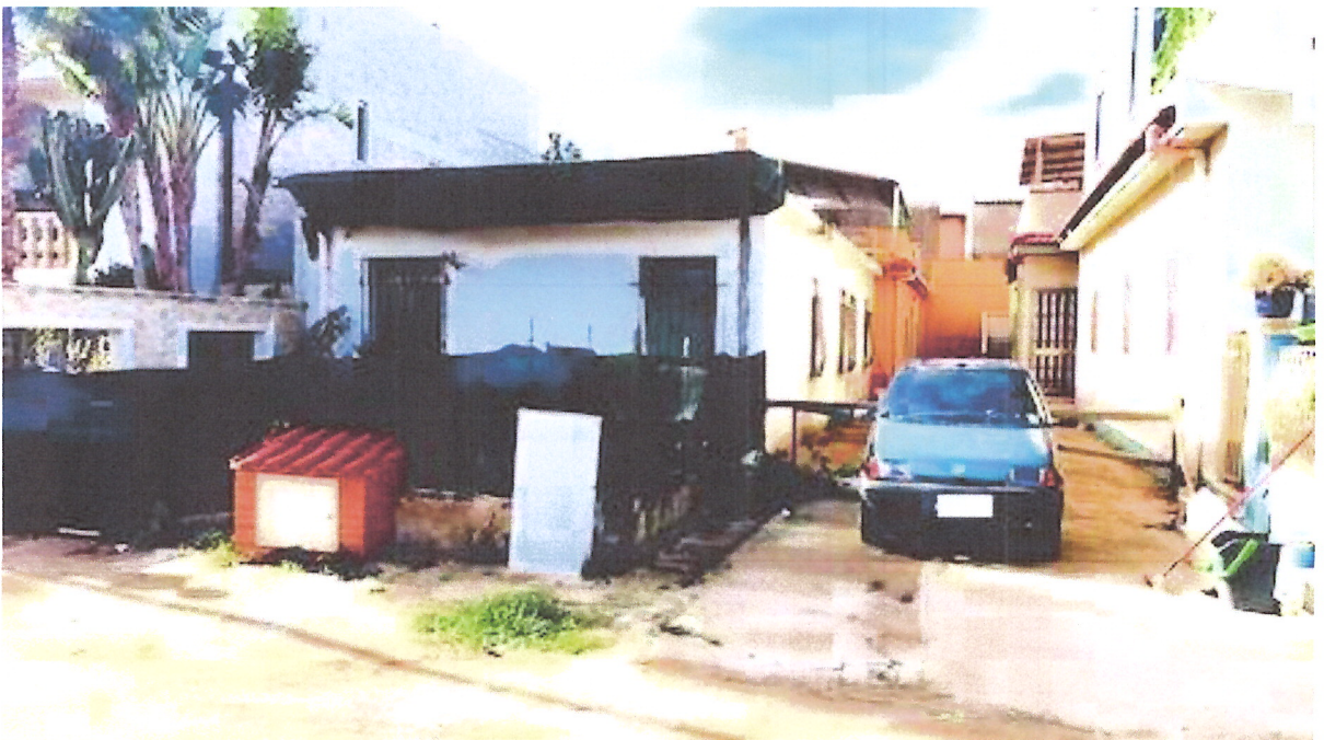
Foto 19 Messa in sicurezza fabbricato a piano terra Vittoria Foglio 190 particella 870 sub 1
