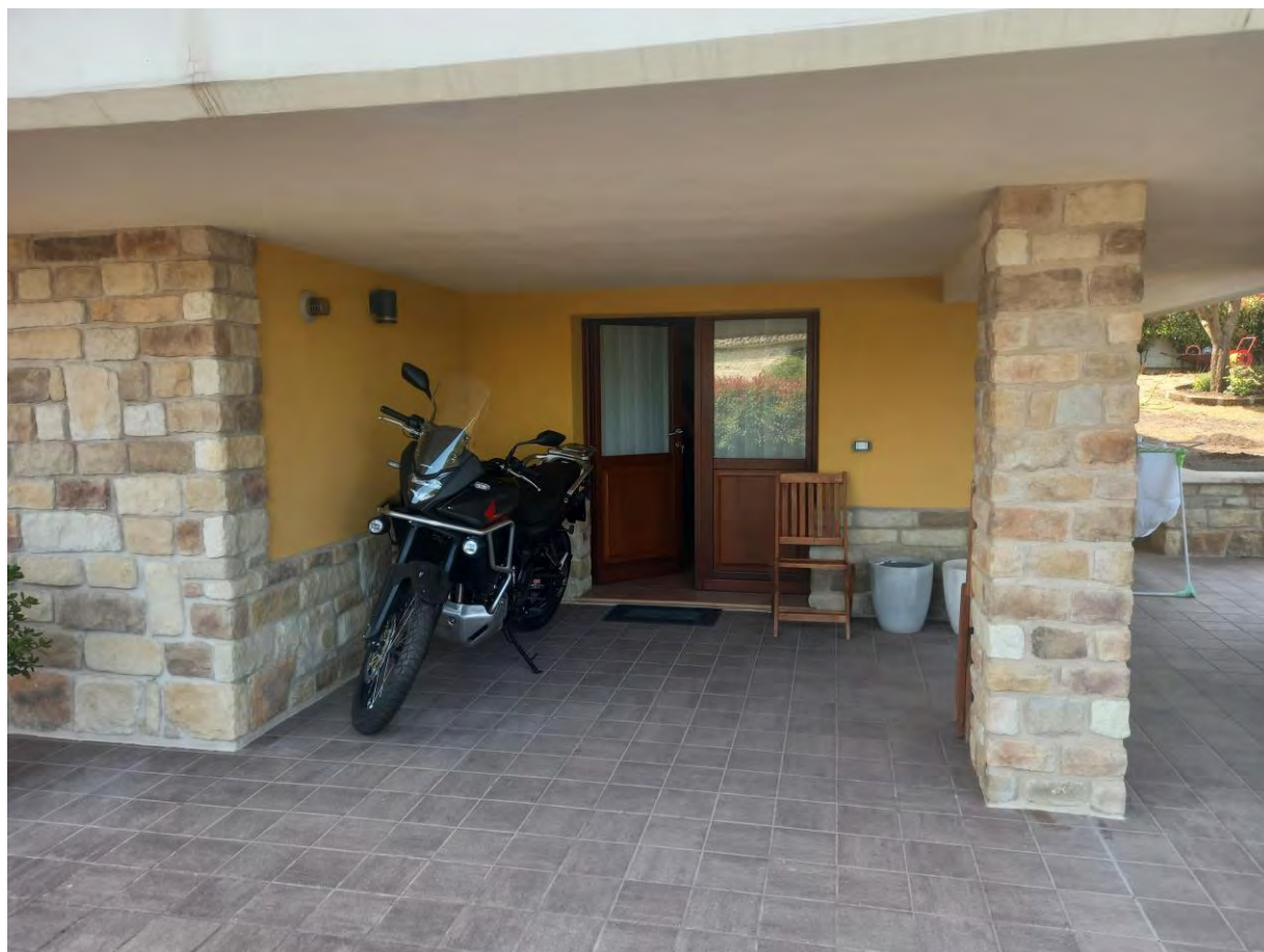
FOTO 6 – PROSPETTO NORD (ingresso taverna)
