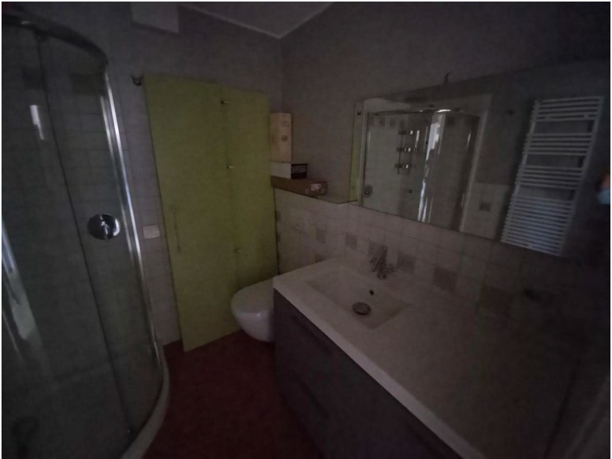
FOTO 17 – BAGNO 2 PIANO TERRA
