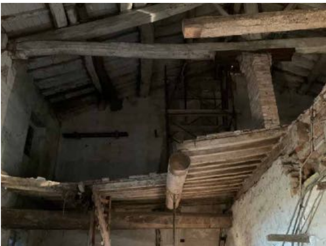
foto 16 - vista locali di deposito (mapp.le 278)
