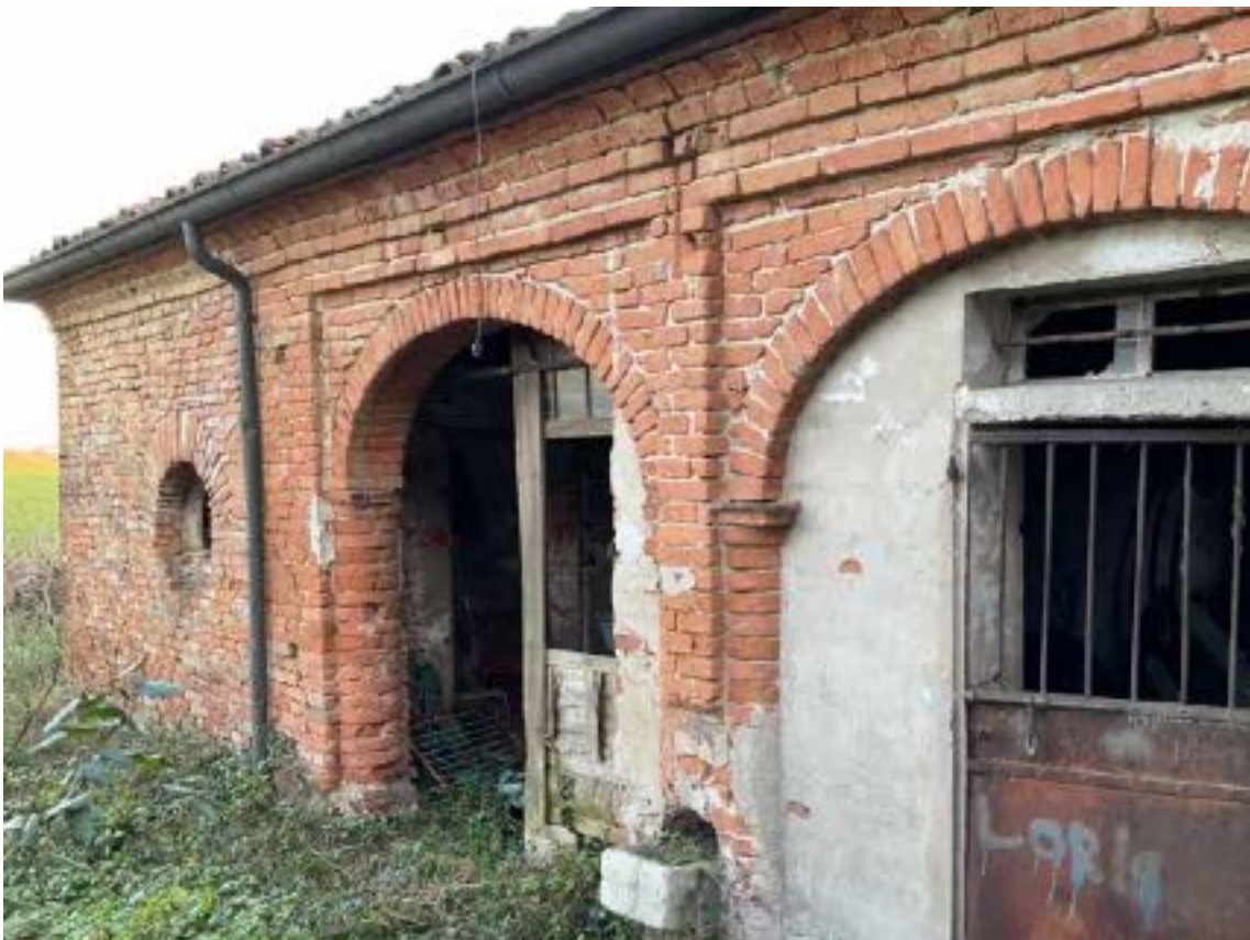
foto 32 - vista abitazione (mapp.le 278)
