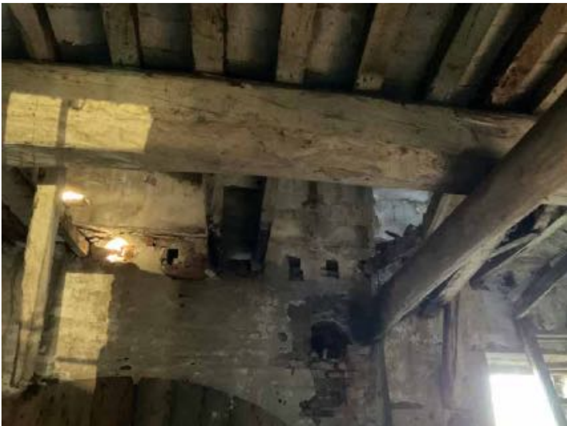
foto 18 - vista locali di deposito (mapp.le 278)
