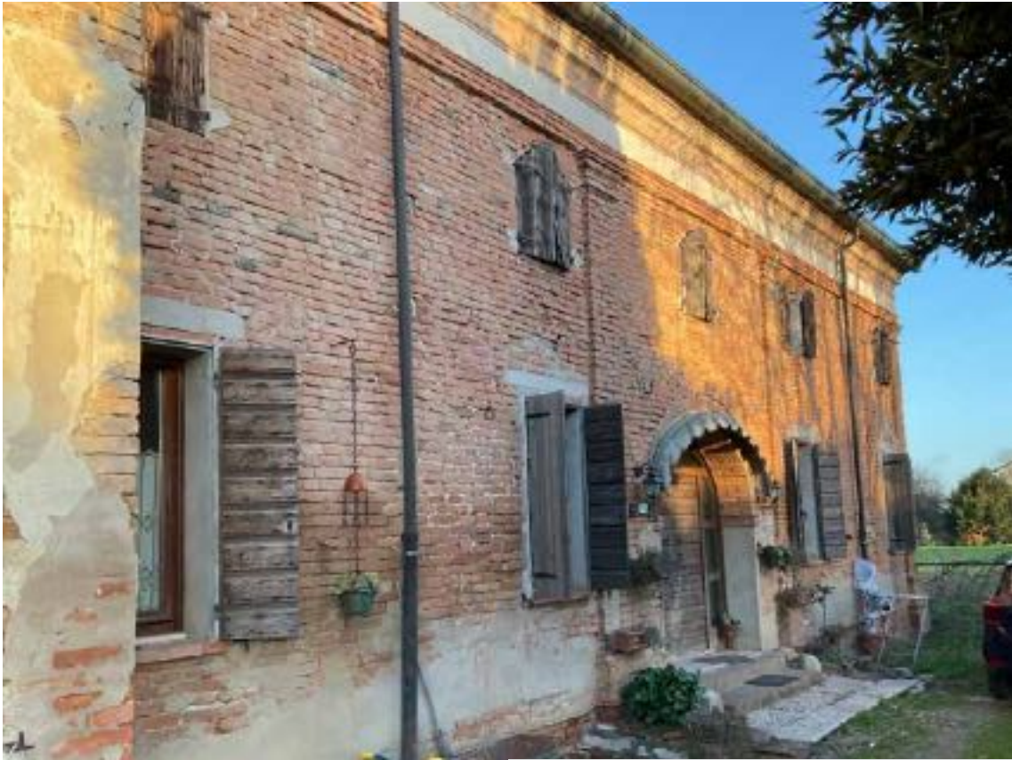
foto 31 - vista abitazione (mapp.le 278)
