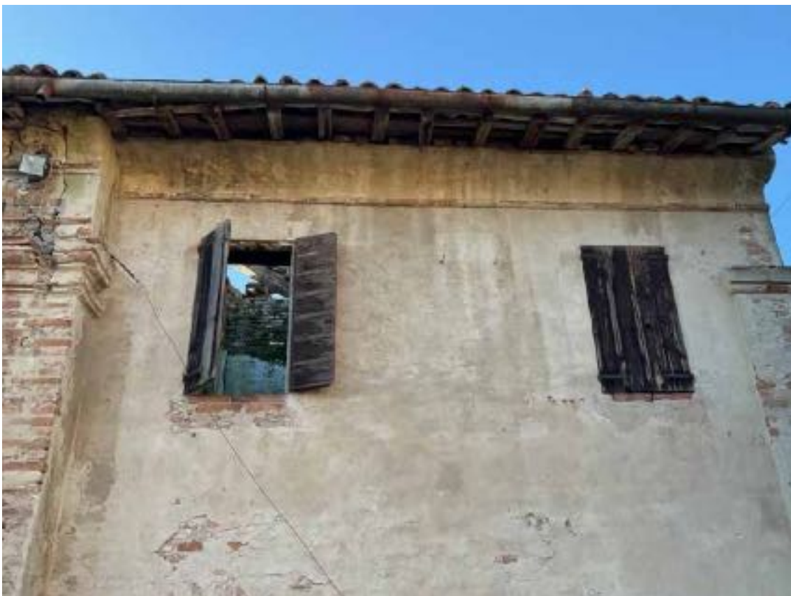
foto 11 - vista abitazione (mapp.le 279)
