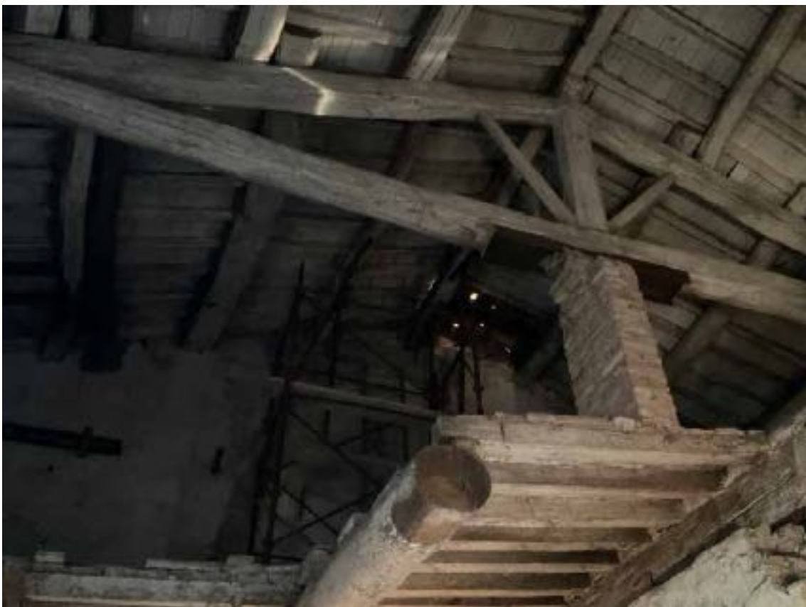
foto 15 - vista locali di deposito (mapp.le 278)
