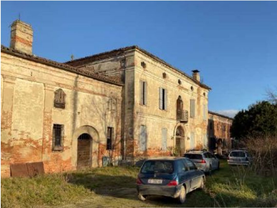
foto 13 - vista locali di deposito (mapp.le 278)
