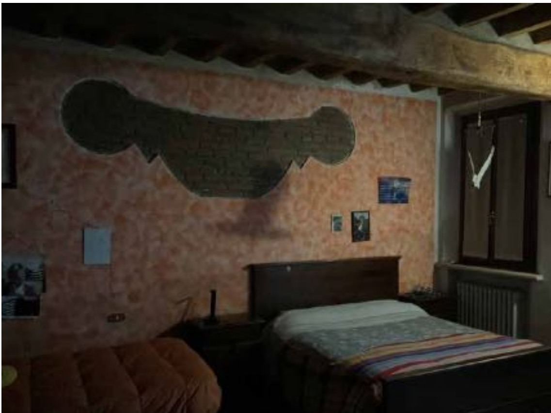
foto 40 - vista abitazione (mapp.le 278)
