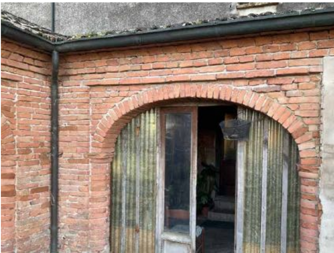
foto 34 - vista abitazione (mapp.le 278)
