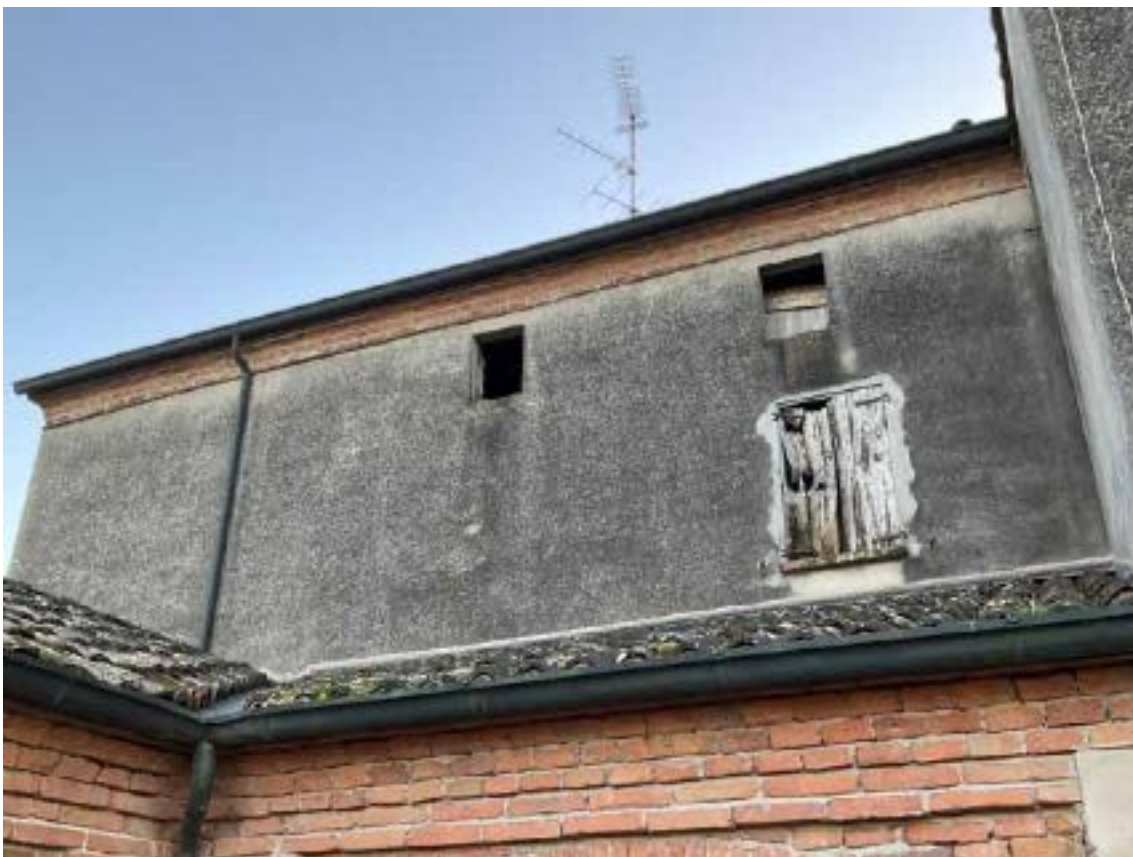
foto 33 - vista abitazione (mapp.le 278)
