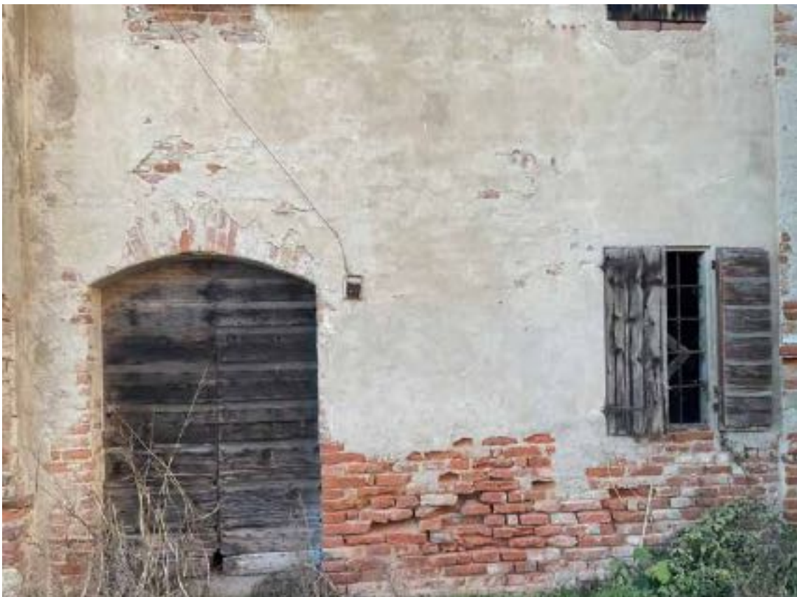
foto 10 - vista abitazione (mapp.le 279)
