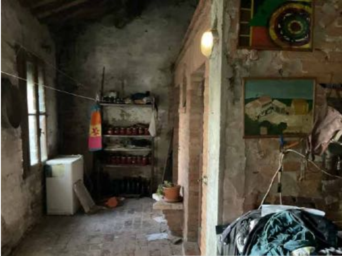
foto 43 - vista abitazione (mapp.le 278)
