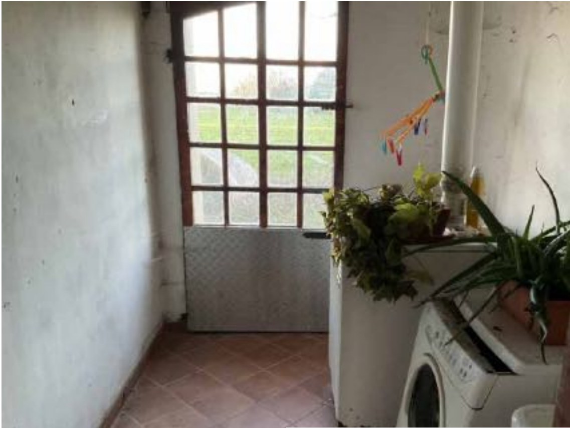
foto 45 - vista abitazione (mapp.le 278)
