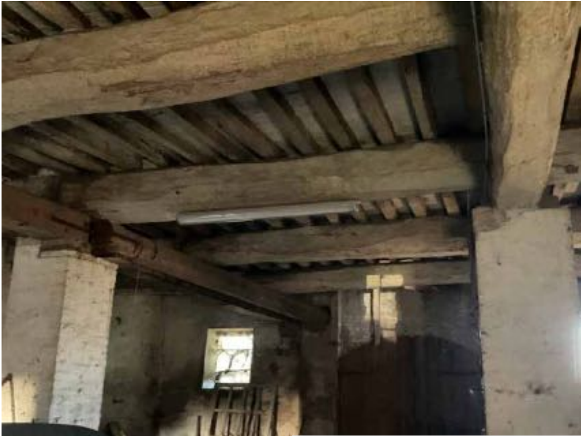
foto 17 - vista locali di deposito (mapp.le 278)
