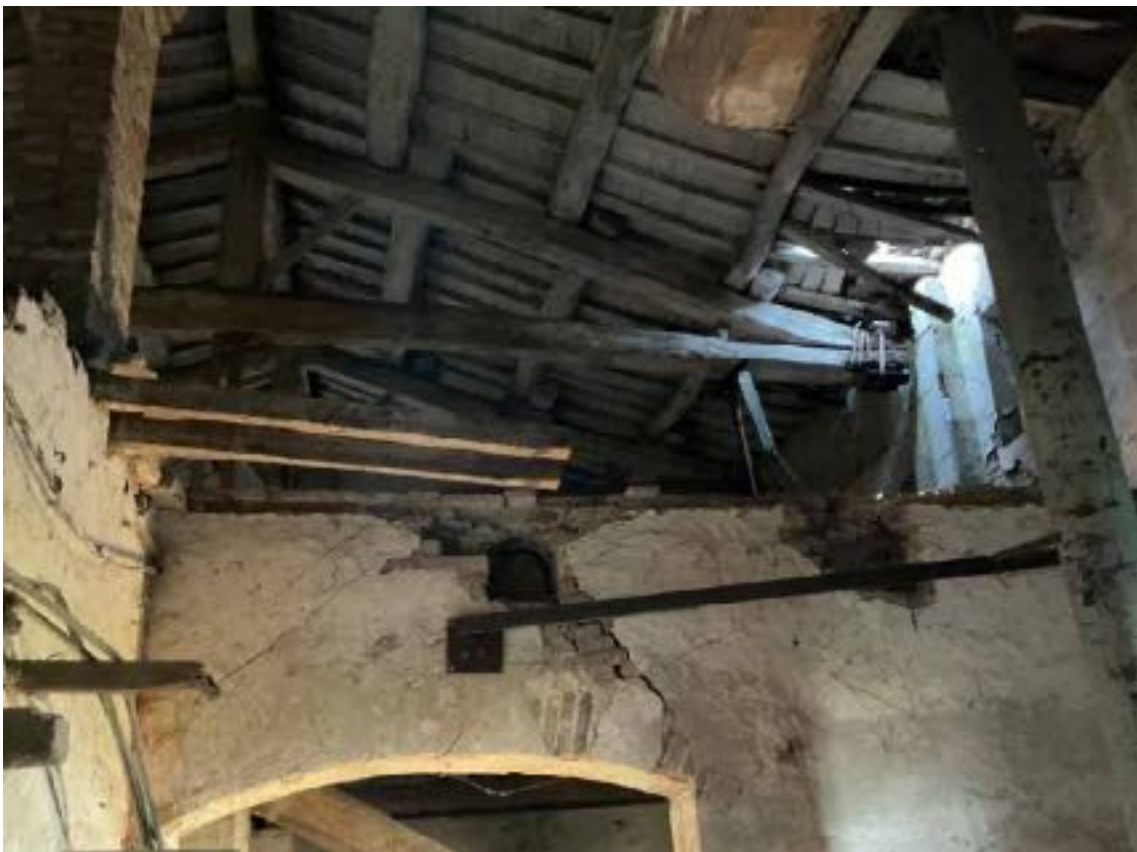
foto 14 - vista locali di deposito (mapp.le 278)
