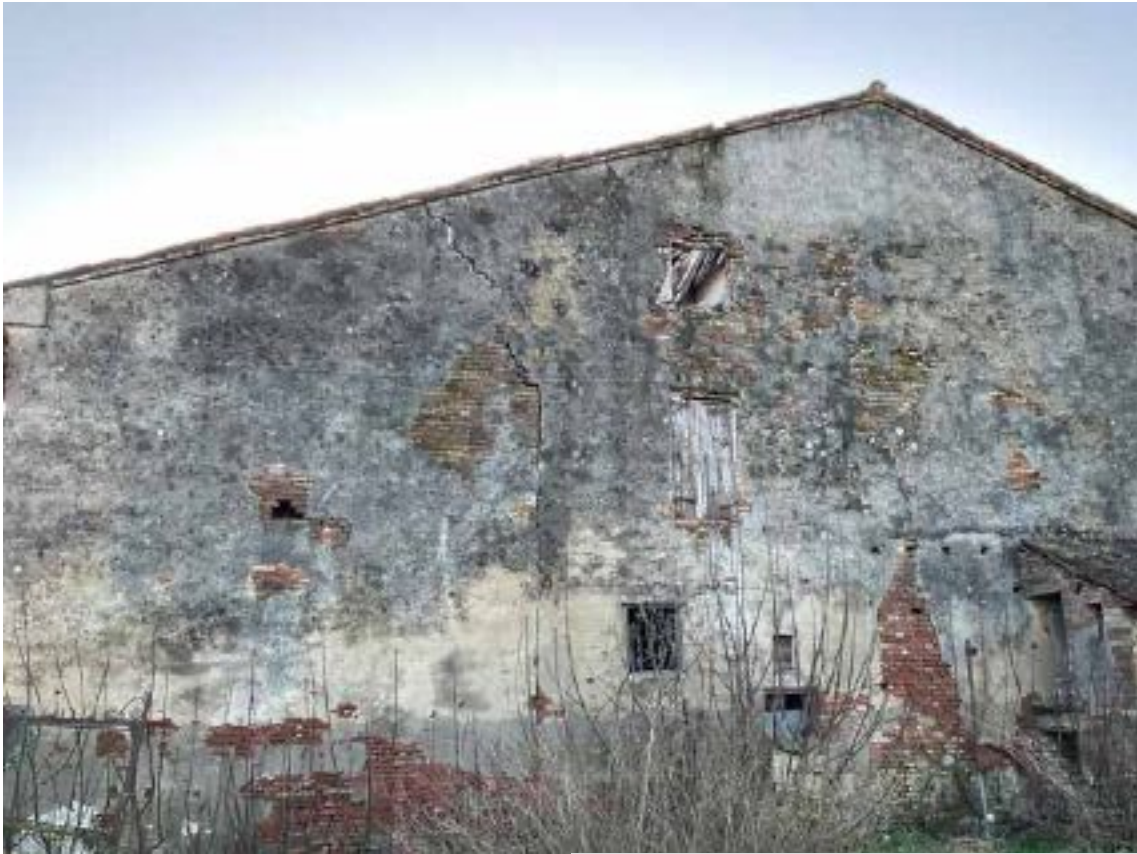
foto 09 - vista abitazione (mapp.le 279)
