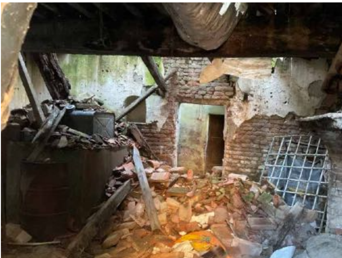
foto 12 - vista abitazione (mapp.le 279)
