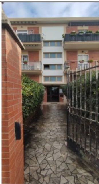
Foto n.5 Vista dell'ingresso alla palazzina Civ. 12
