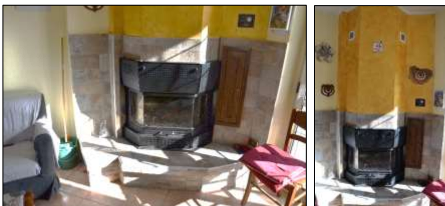
Figura 35 - Termocamino ubicato nel vano CUCINA
