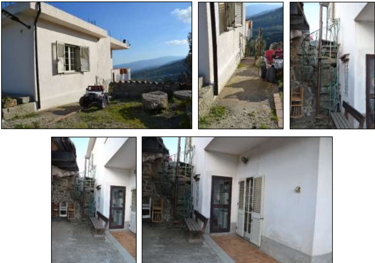
Figura 10 - Scala a chiocciola di collegamento dei due livelli della corte (subalterno 6)
