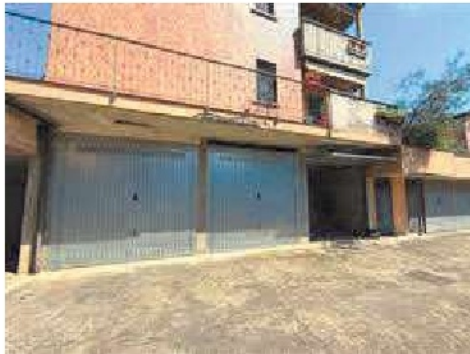
Il lotto in vendita è il box alla sinistra della serranda aperta
