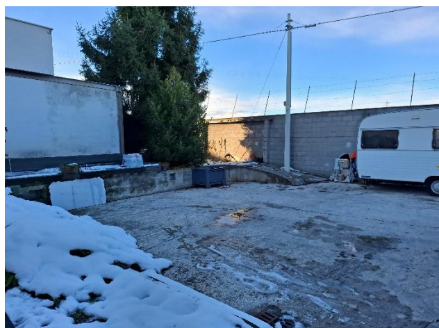
Figura: vista cortile a nord, rif alloggio sub.24 (bene 1)
