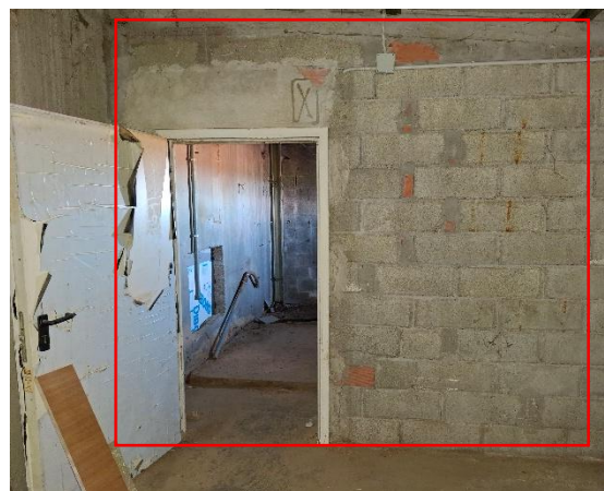
Figura: Tamponamento oggetto di demolizione o regolarizzazione che delimitava locale compressore.
