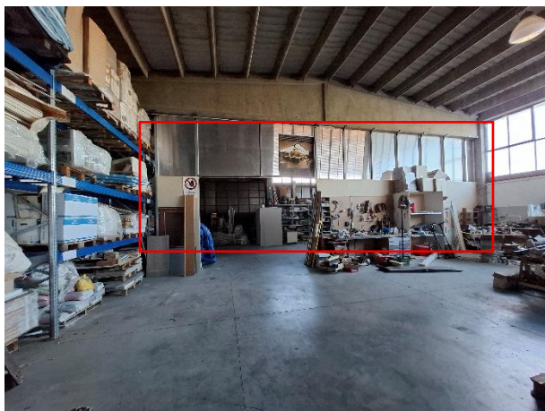
Figura: struttura leggera di divisione, oggetto di demolizione o regolarizzazione
