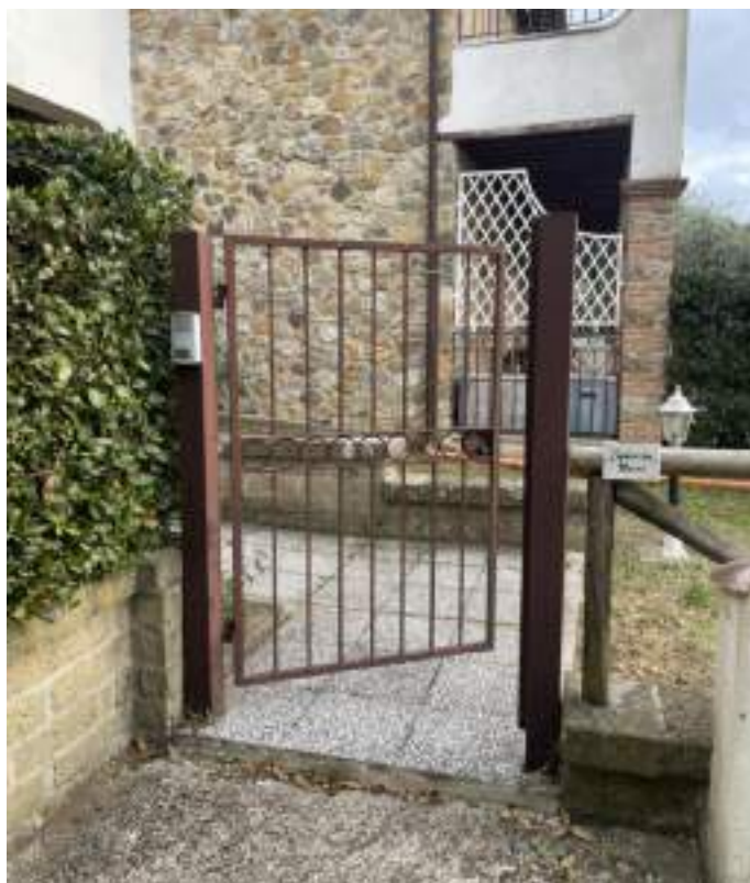
Vista del cancello di ingresso alla corte esclusiva.
