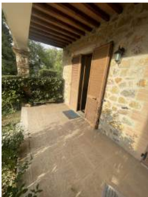
Vista 2 del portico, verso corte esclusiva di altra proprietà.
