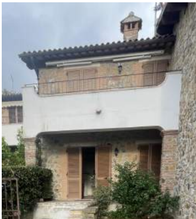
Vista della facciata di ingresso.
