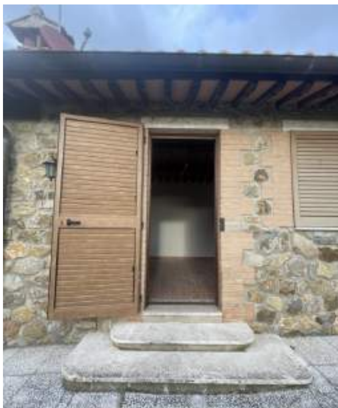
Vista dell'ingresso all'appartamento.
