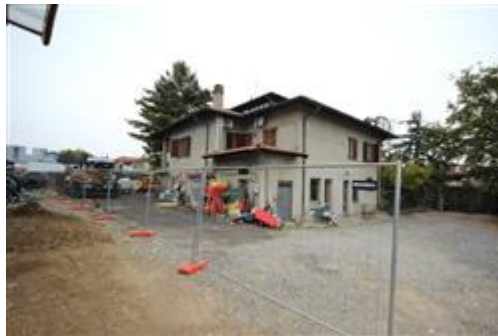
Veduta esterno edificio
