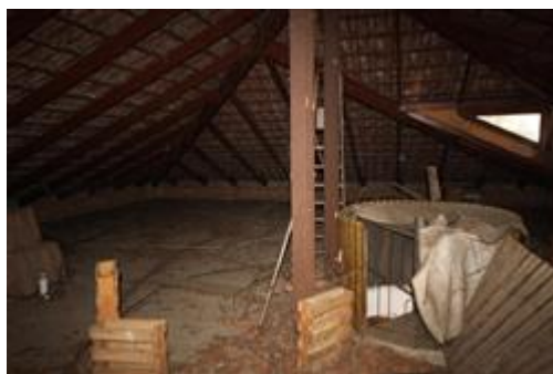
Scala di collegamento piano 1°/sottotetto
