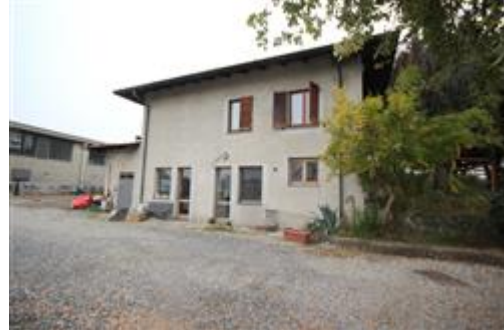
Veduta esterno edificio
