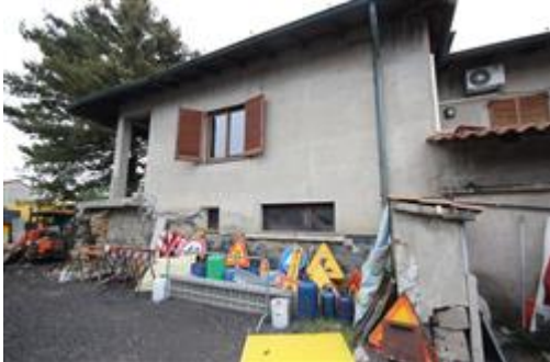
Veduta esterno edificio
