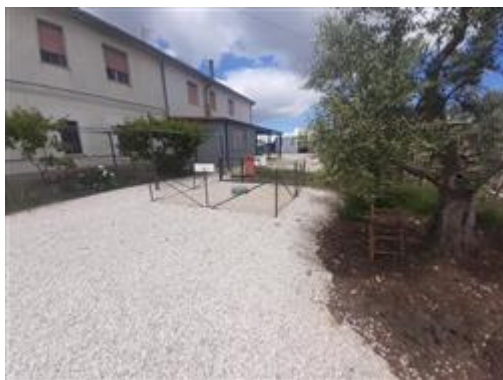
Veduta porzione p.lla 164
