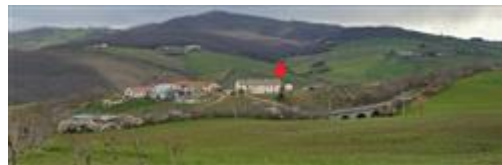
Veduta dell'area dalla S.S. n. 87
