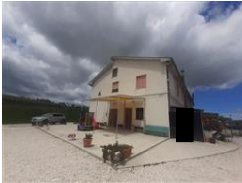
Veduta esterna: zona ingressi (fronte sud)
