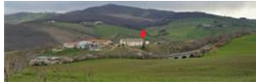
Veduta dell'area dalla S.S. n. 87
