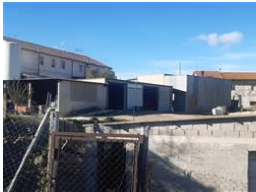
Veduta esterna d'insieme
