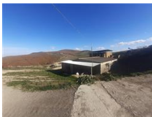
Veduta esterna fronte nord
