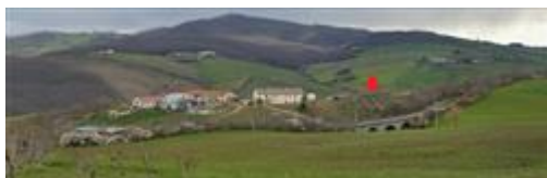
Veduta dell'area dalla S.S. n. 87
