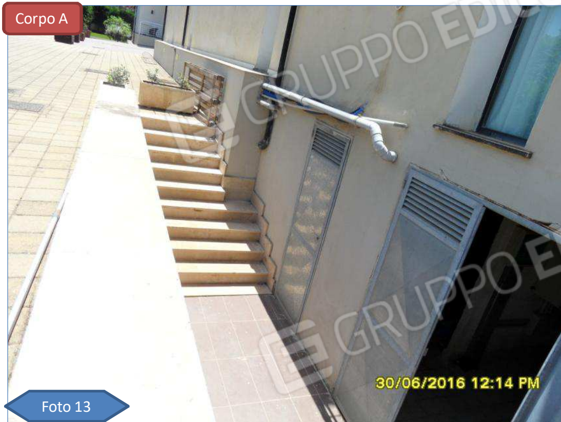
Accesso ai locali tecnici.
