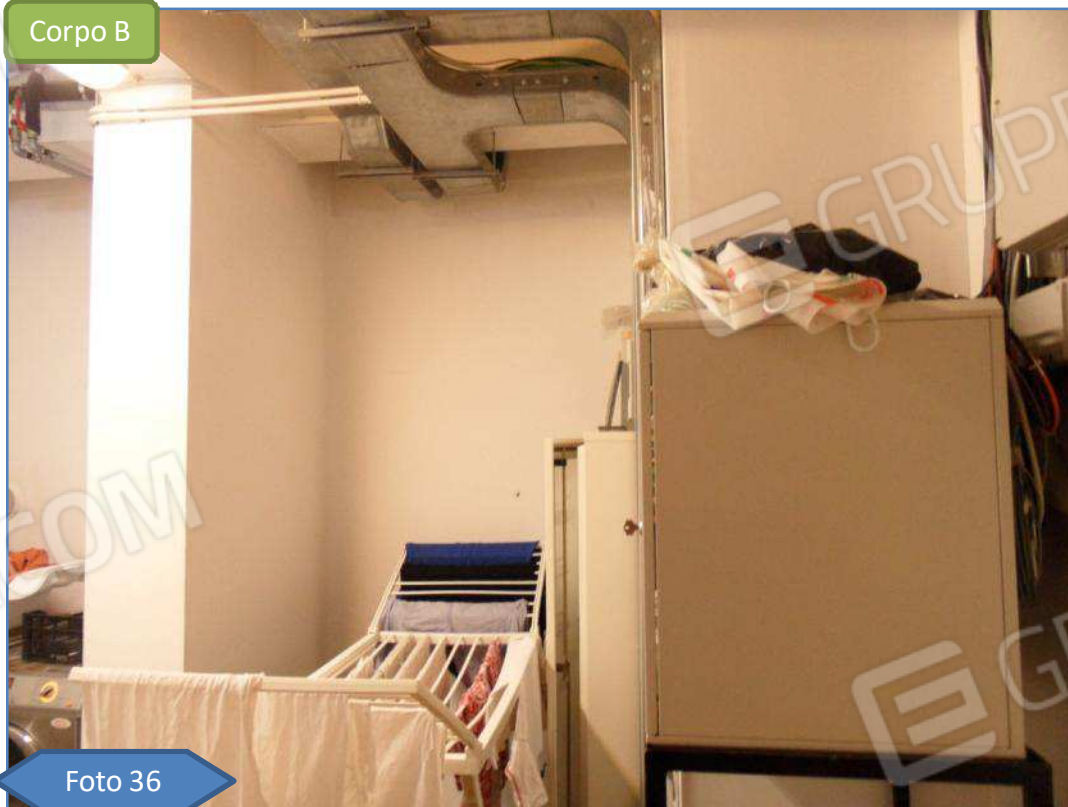
Ulteriore vista della lavanderia.
