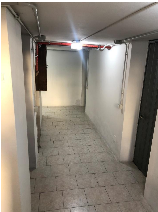
Figura 26 – Corridoio comune a piano interrato
