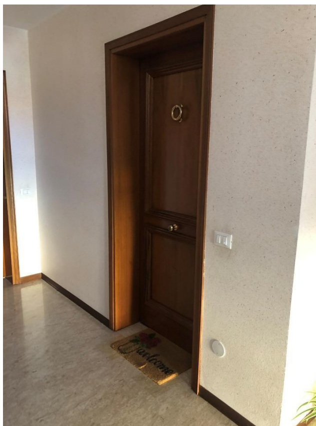
Figura 27 – Portoncino di ingresso dell'appartamento pignorato
