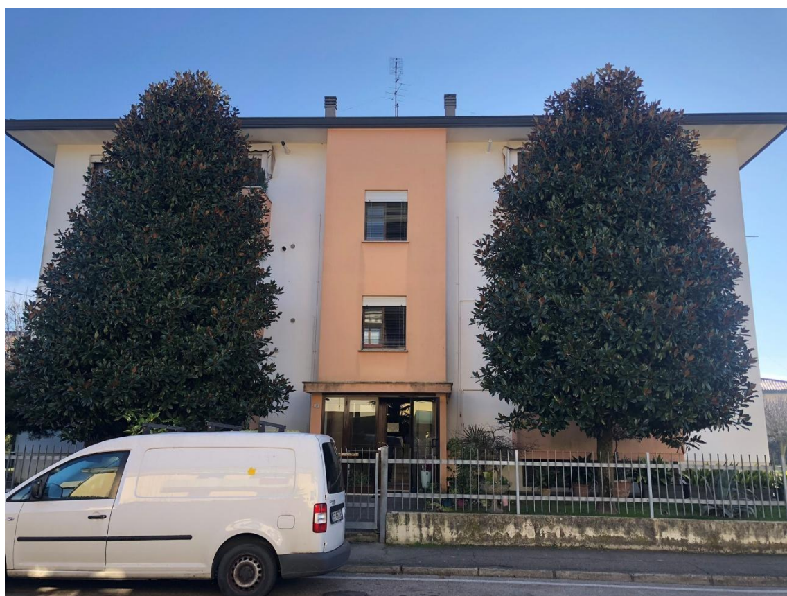
Figura 8 – Facciata su via Mascagni
