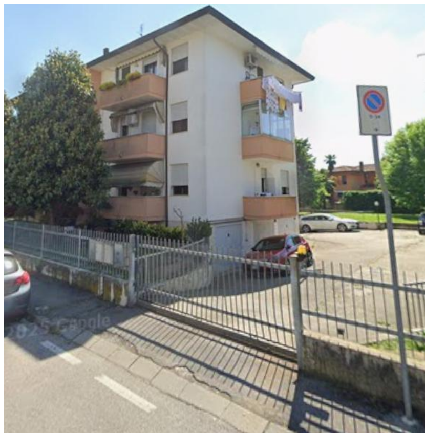
Figura 18 – Accesso carraio comune ai fabbricati eretti sui mappali 1447 e 1878
