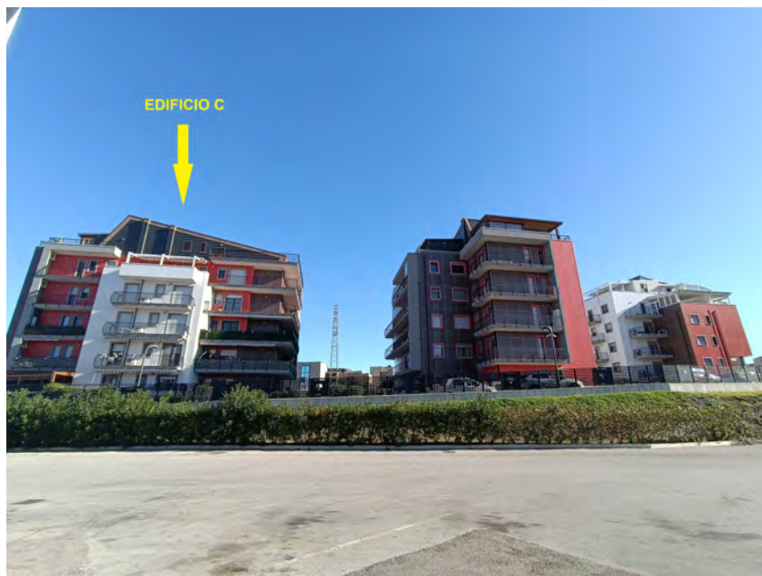
FOTO N.04 Individuazione Edificio C
