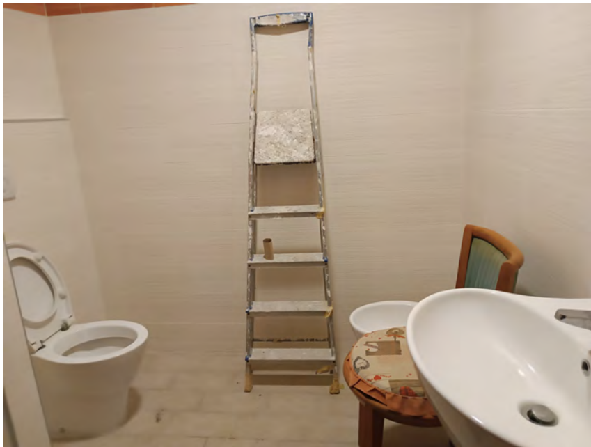
FOTO N.08 Interno del box
