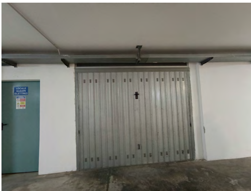
FOTO N.07 Accesso al box
