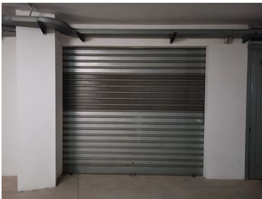
FOTO N.07 Accesso al box
