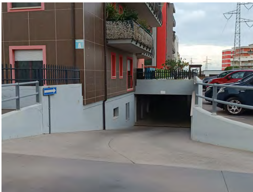
FOTO N.05 Rampa di accesso al piano dei box
