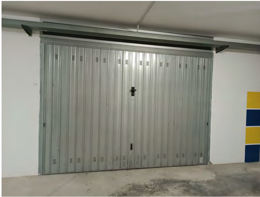
FOTO N.07 Accesso al box
