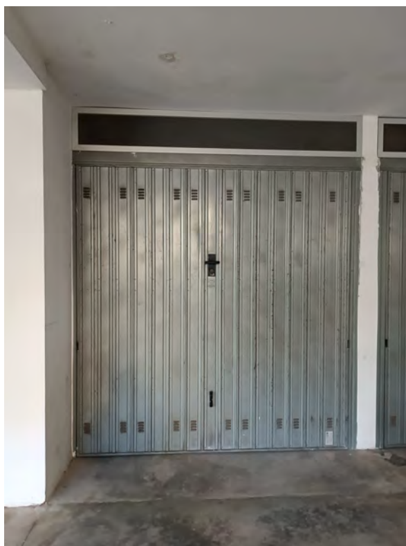
FOTO N.07 Accesso al box
