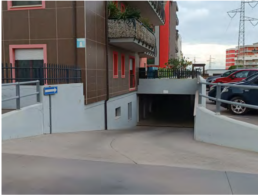
FOTO N.05 Rampa di accesso al piano dei box
