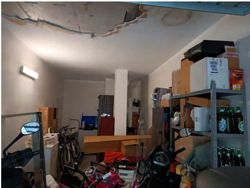
FOTO N.08 Interno del box
