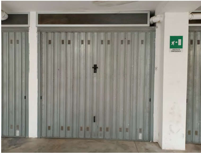
FOTO N.07 Accesso al box
