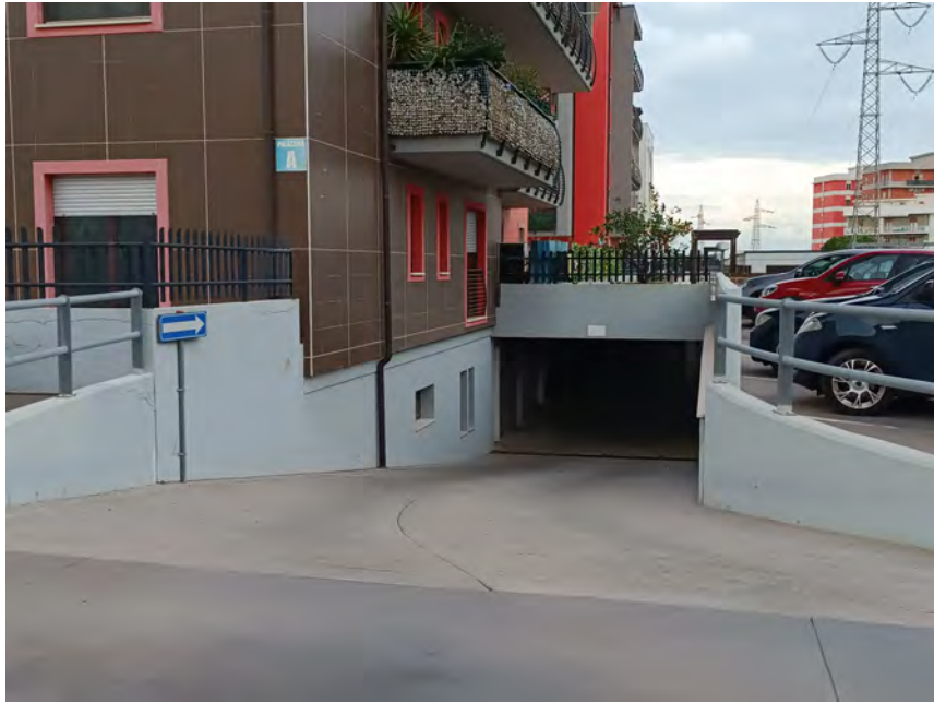
FOTO N.05 Rampa di accesso al piano dei box
