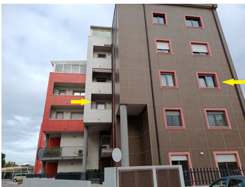
FOTO N.06 Individuaz. appartamento - Edificio A, 2° piano, interno 9
