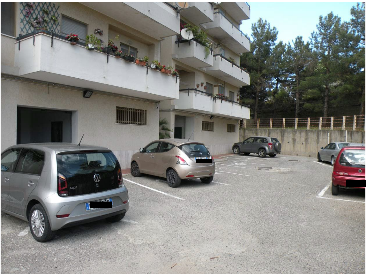
Foto n° 2 – Edificio sito in località Aranceto di Catanzaro – Via Teano n° 27/A, in cui si trova al piano terzo l'alloggio pignorato – Corte recintata
