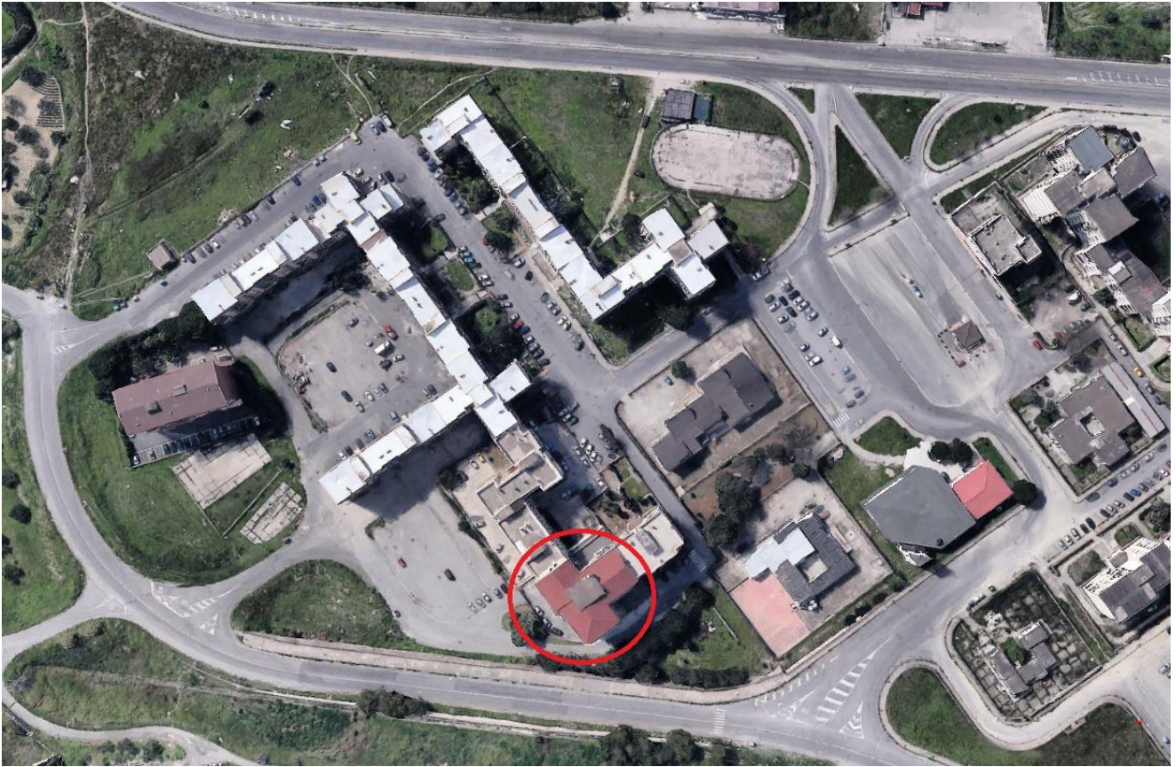
Fig. 2 – Ubicazione del fabbricato in cui si trova l’immobile pignorato su ortofotografia
