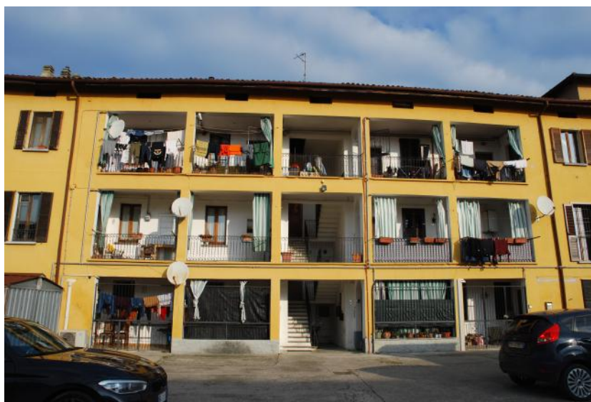
Fronte verso il cortile
