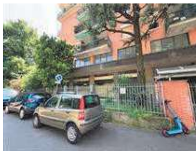
Fabbricato in cui risiede il lotto oggetto di stima
