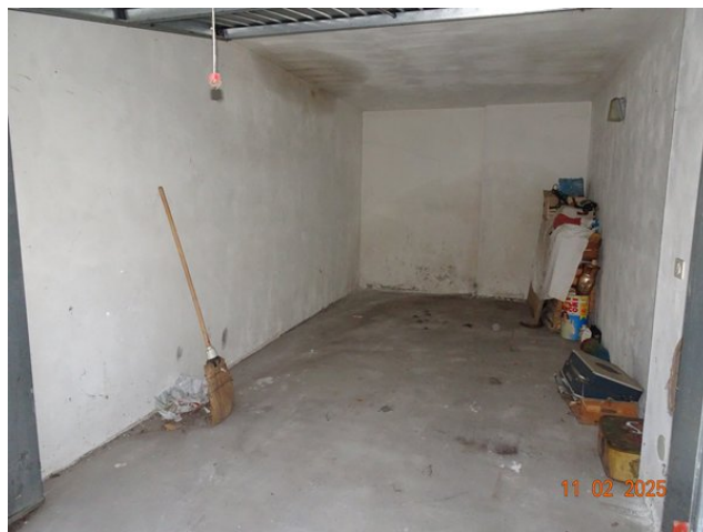
Interno locale autorimessa privata
