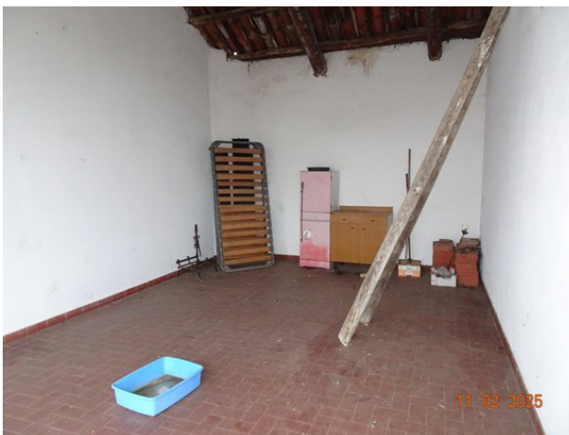
Locale deposito aperto
