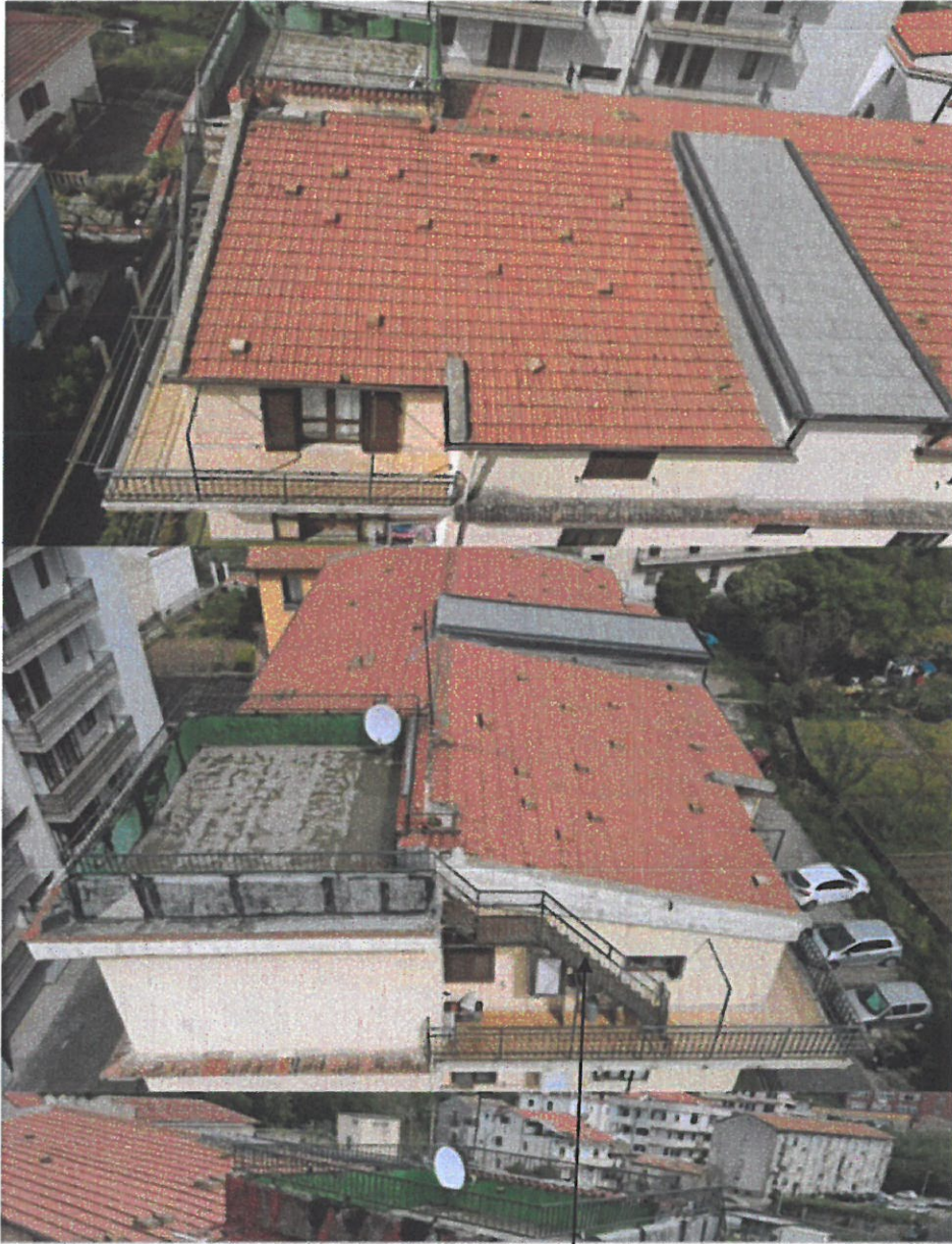
Scala in ferro che collega i due livelli .
