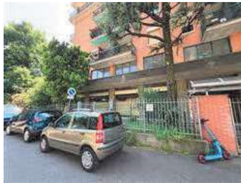
Fabbricato in cui risiede il lotto oggetto di stima
