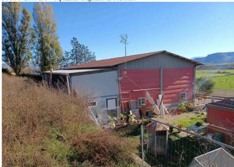
FOTO 4- Lotto n. 1 – Capannone artigianale in Colferro
