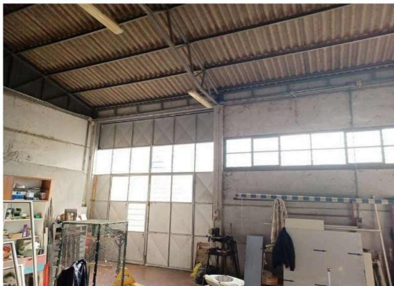
FOTO 7- Lotto n. 1 – Capannone artigianale in Colleferrro
