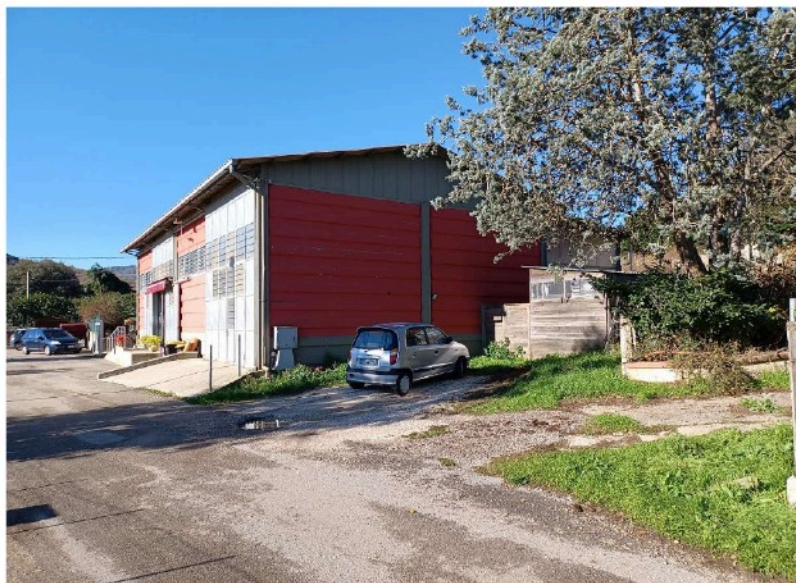
FOTO 3- Lotto n. 1 – Capannone artigianale in Colferro
