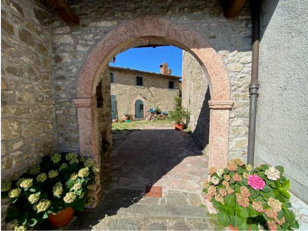
Accesso immobili pignorati (mappale 4331)
