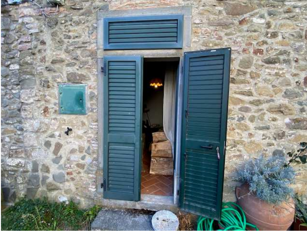
Accesso secondario all'immobile (4329) pignorato
