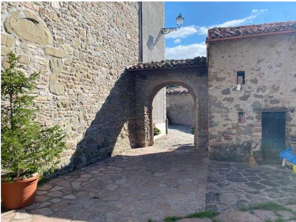
Accesso immobili pignorati (mappale 4331)
