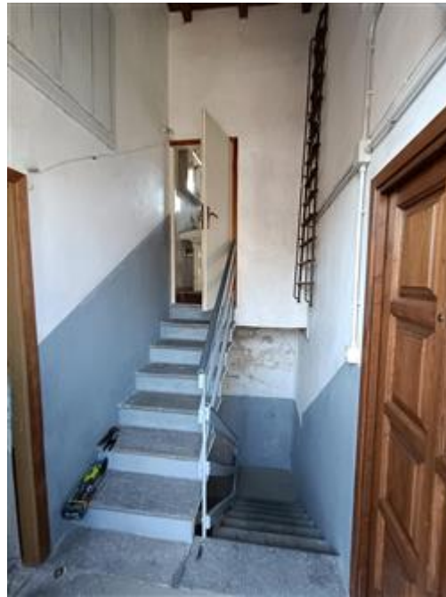
BALLATOIO VANO SCALA PIANO SECONDO CON WC COMUNE
