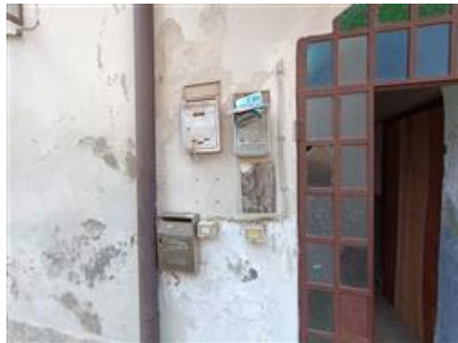
INGRESSO PIANO TERRENO
