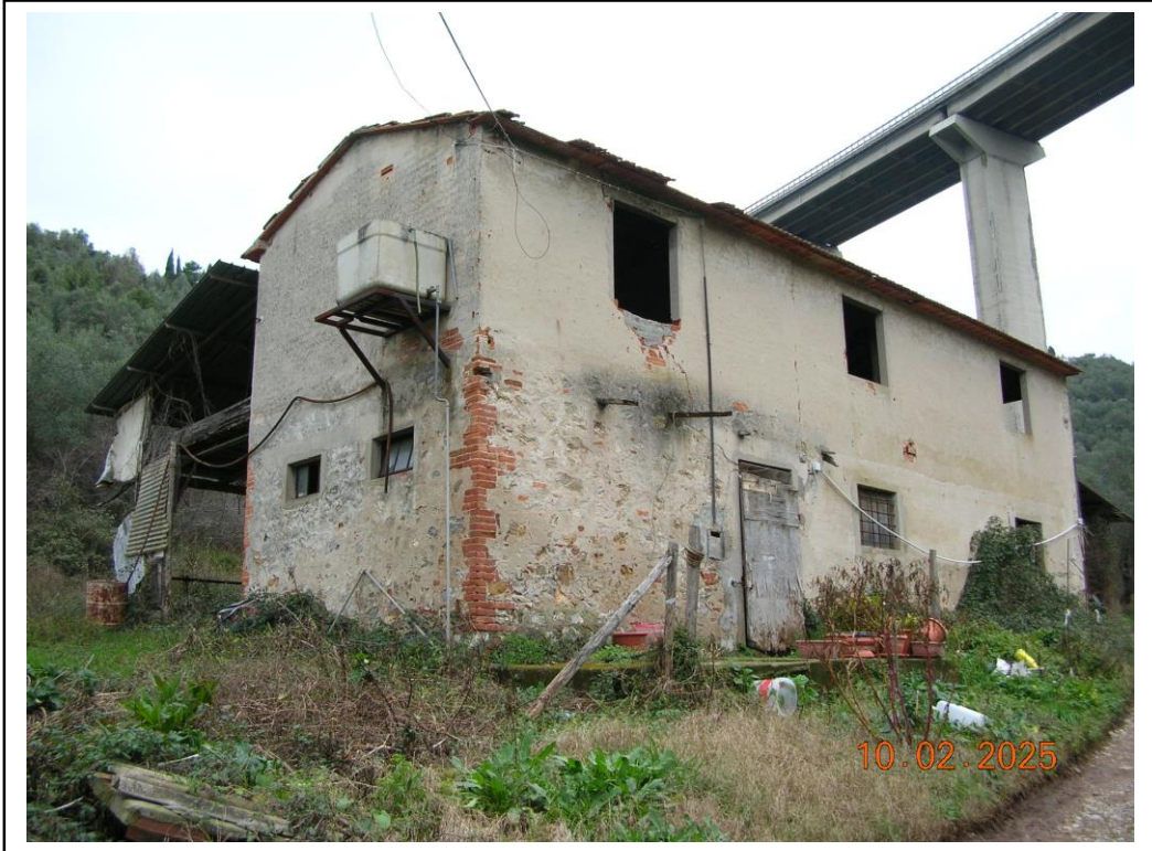
Foto 1 Prospetto Sud - Est
