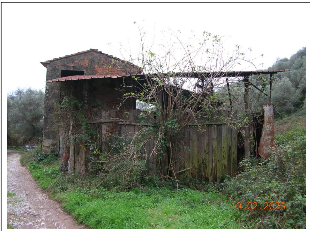
Foto 4 Prospetto Nord - Est
