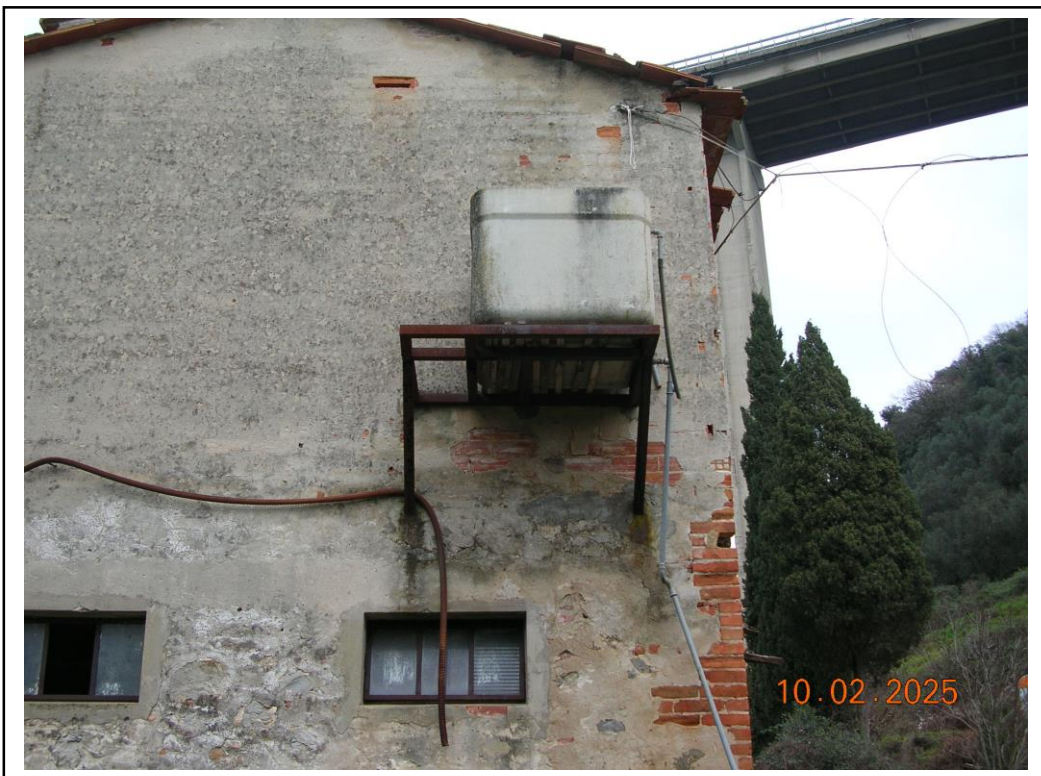
Foto 14 Cassone in cemento amianto
