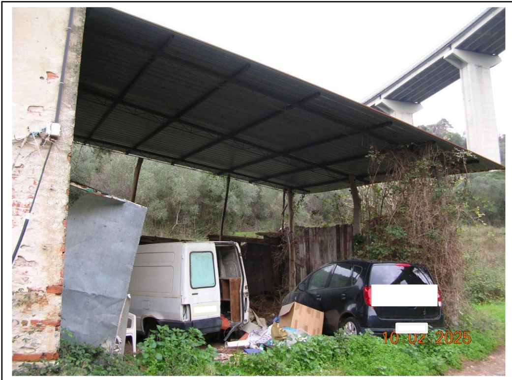
Foto 3 Tettoia ad Est del fabbricato
