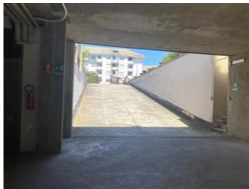
Rampa comune di accesso
