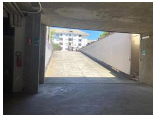
Rampa comune di accesso
