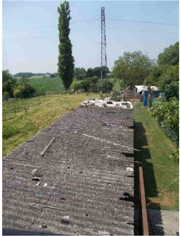
Foto 11- Annesso- deposito attrezzi- copertura in eternit
