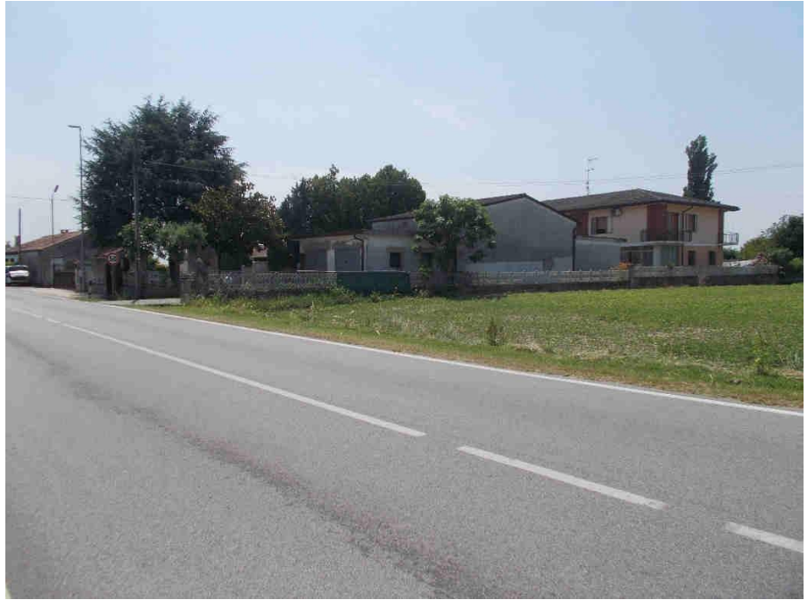
Foto 1- Vista complessiva esterna da nordovest
