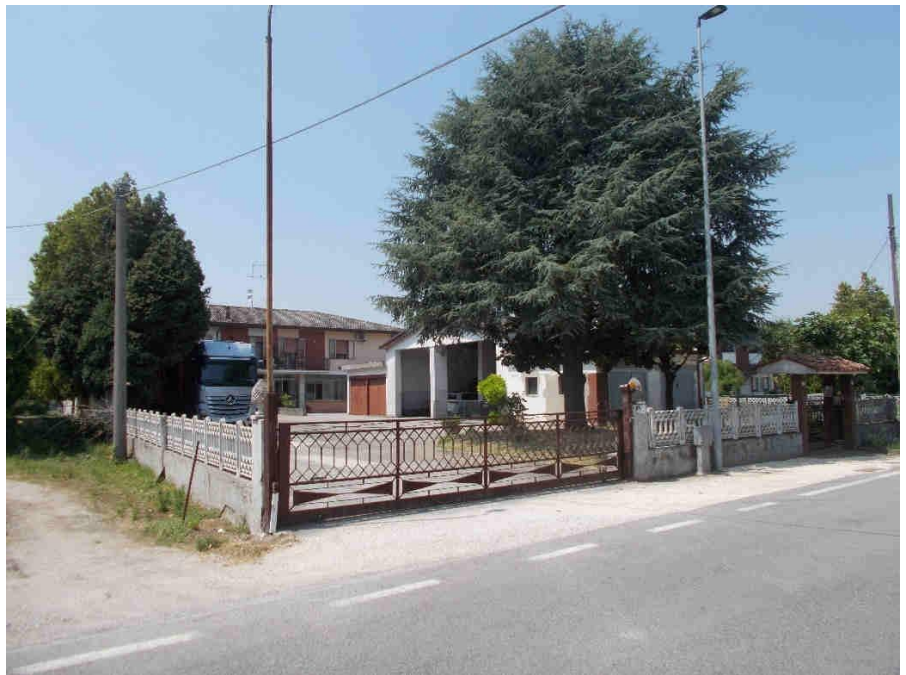
Foto 2- Vista complessiva esterna da nordest
