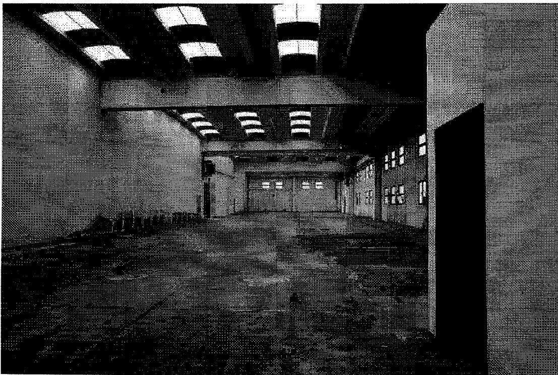
Foto N° 24 vista del terzo ambiente verso sud
