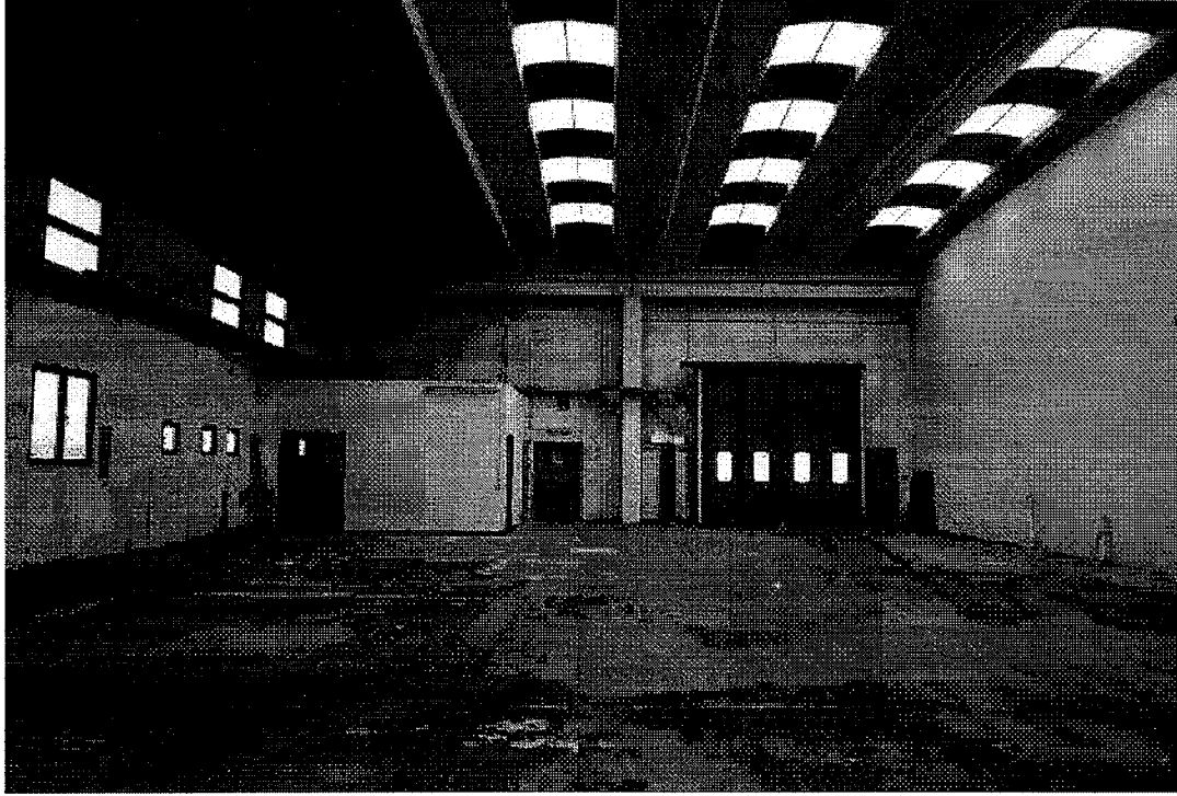
Foto N° 25 vista del terzo ambiente verso il lato nord con servizi
