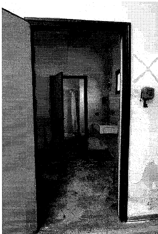
Foto N° 26 vista particolare dei servizi del ambiente terzo
