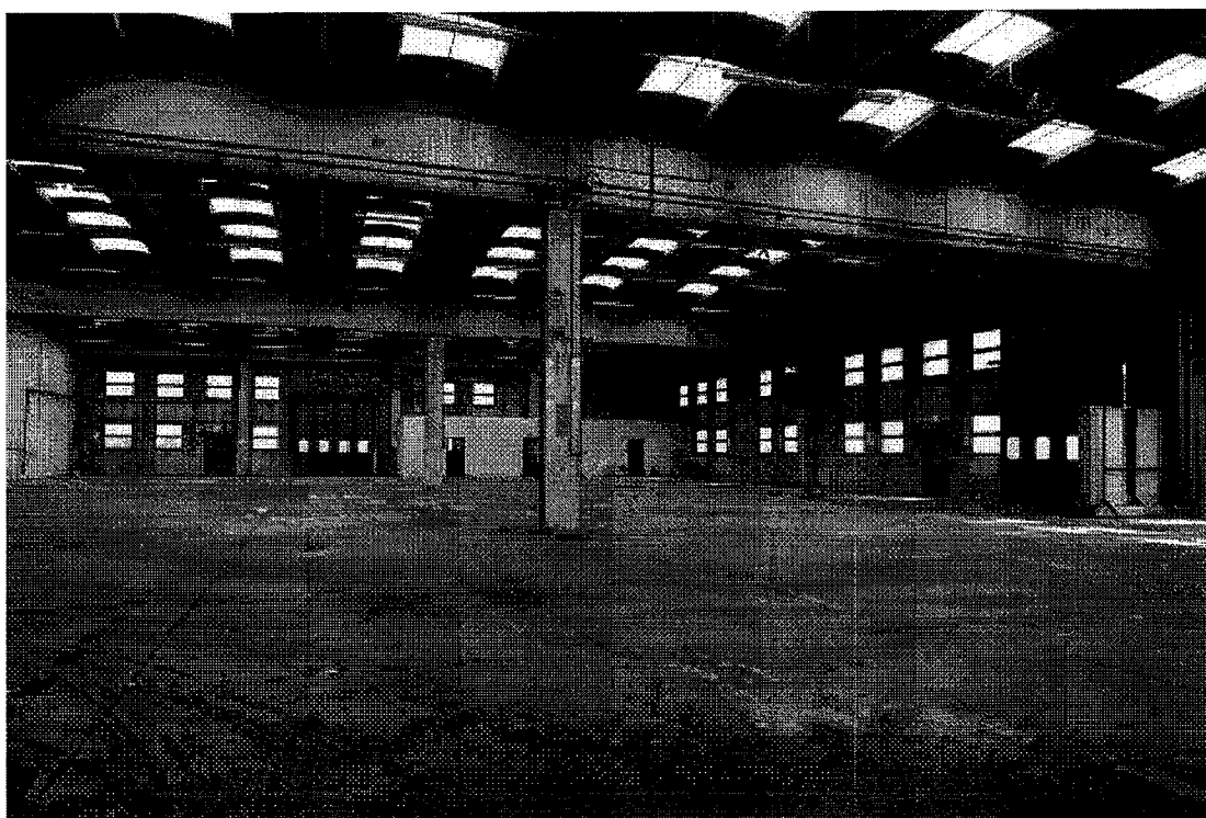
Foto N° 20 vista del secondo ambiente verso nord-est
