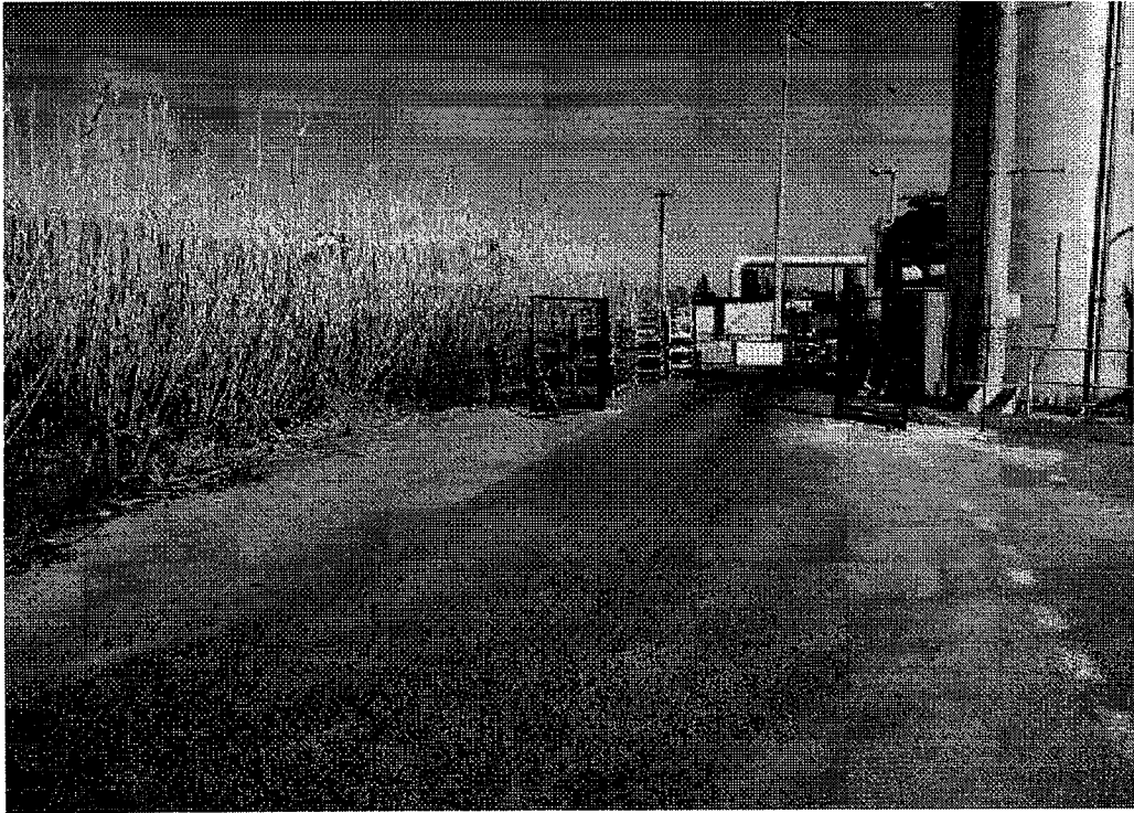
Foto N° 9 cancello di confine ovest-nord
