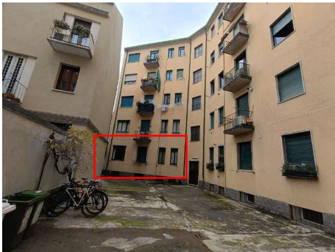
“Edificio interno” e dettaglio dell’unità immobiliare pignorata
