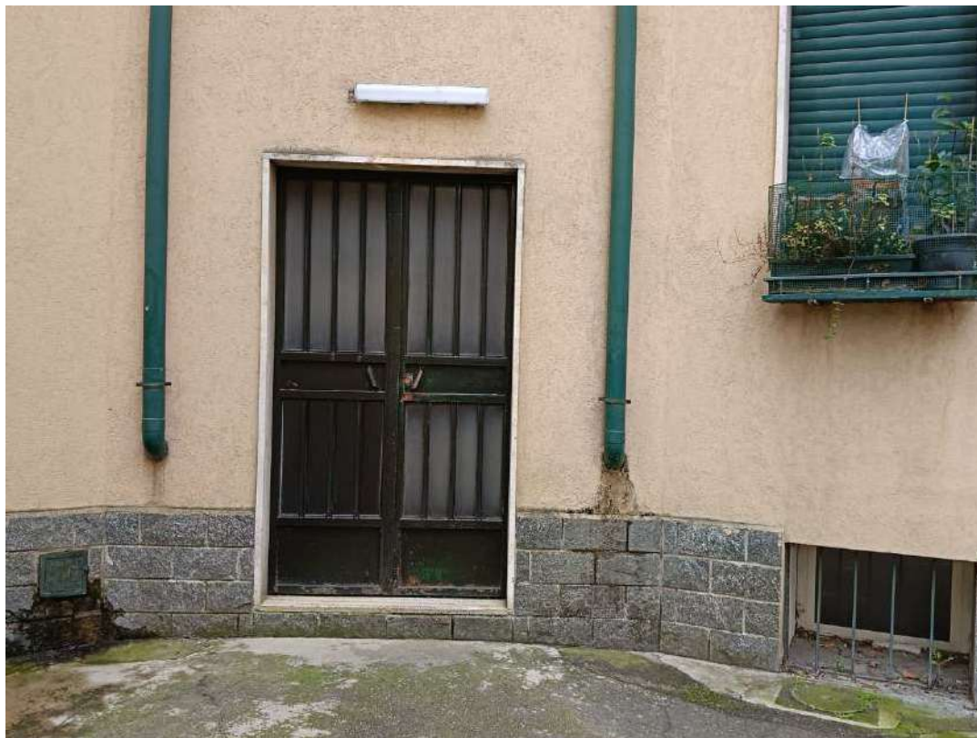
Portone di ingresso dell' "edificio interno"
