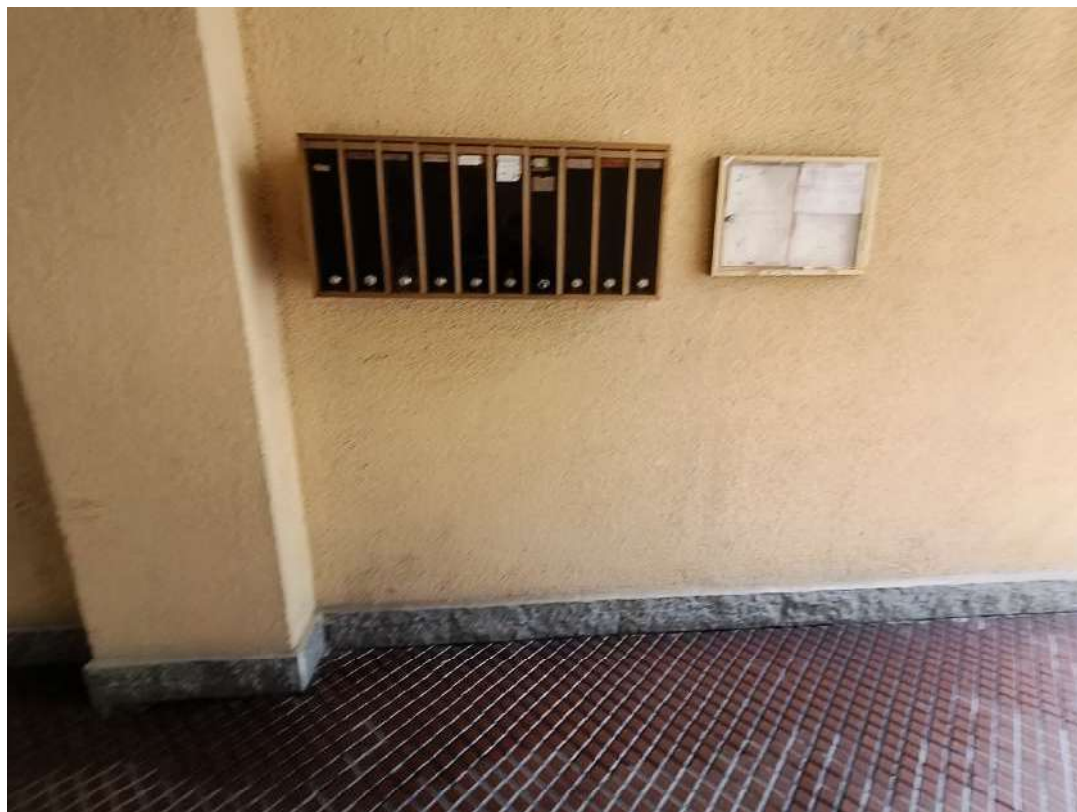
Dettaglio – Caselle postali dell' "edificio interno"
