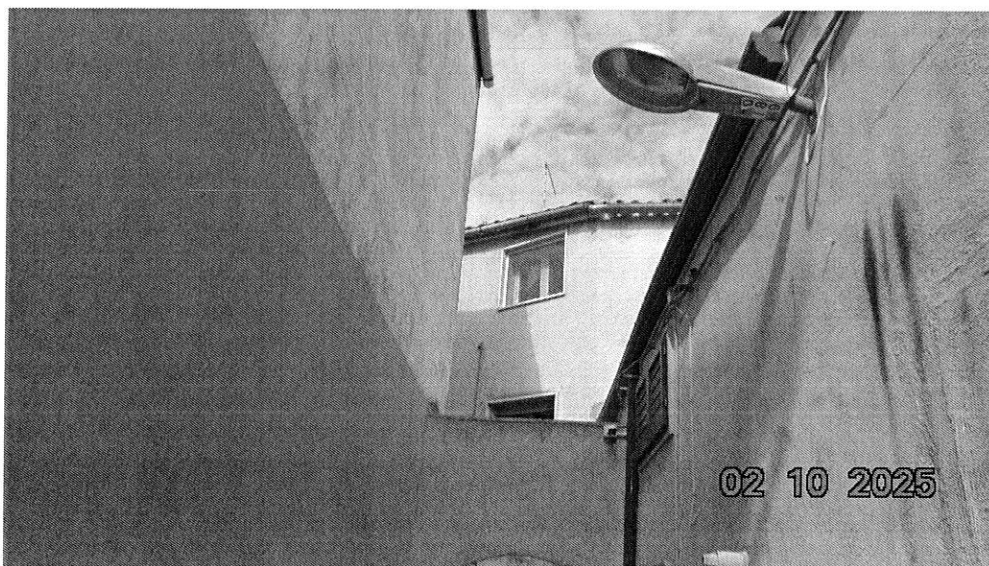
Prospetto esterno e particolare finestra sottotetto
