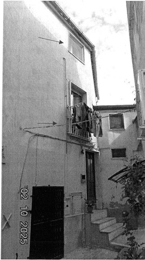
Prospetto esterno e particolare porta finestra soggiorno
