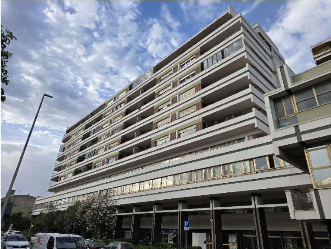
Palazzina corpo B vista via Cagliari
