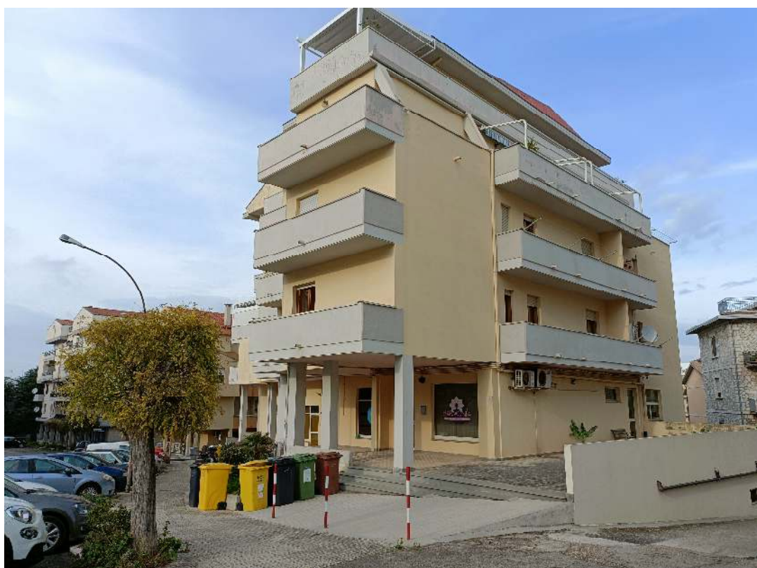
FOTO N. 2 Vista esterna da Via delle Gardenie
