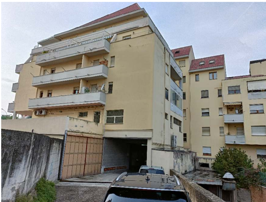
FOTO N. 3 Vista esterna facciata posteriore ingresso garage
