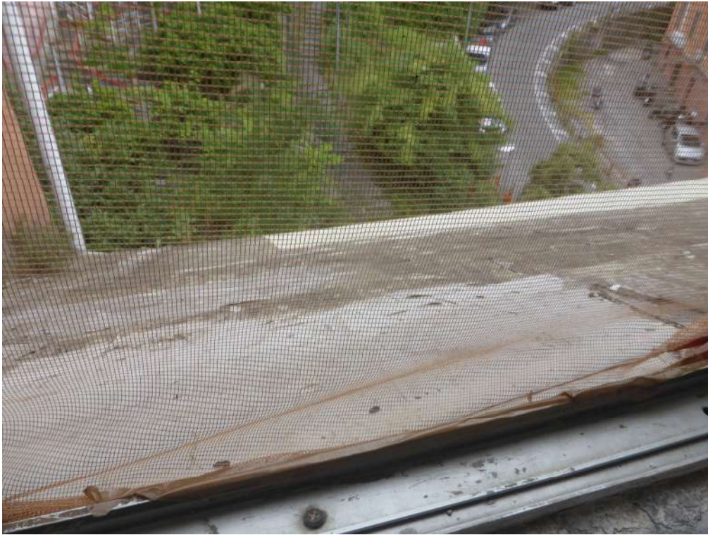
FOTOGRAFIA N. 21 Vista dalla finestra (abbaino) dell'ingresso
