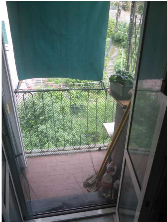
FOTOGRAFIA N. 18 Balcone del bagno
