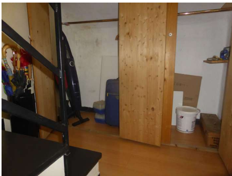
FOTOGRAFIA N. 6 Pianerottolo interno intermedio con armadio a muro
