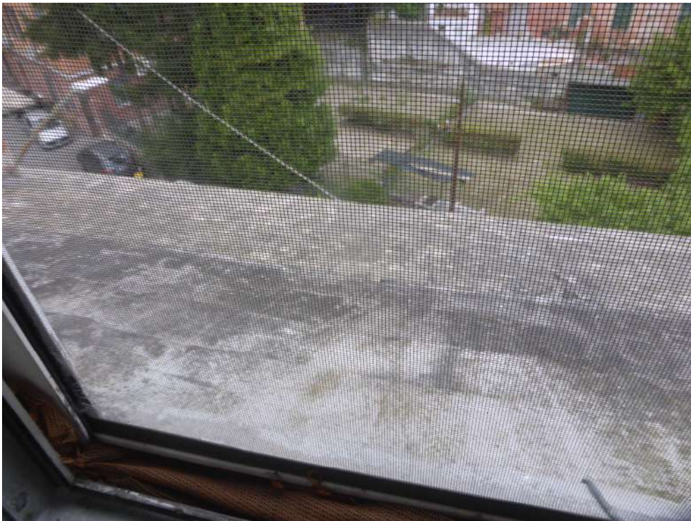
FOTOGRAFIA N. 22 Vista dalla finestra (abbaino) dell'ingresso
