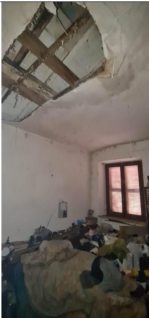
Immobile 3 piano primo – soffitto camera stanza sud con ampia e grave infiltrazione
