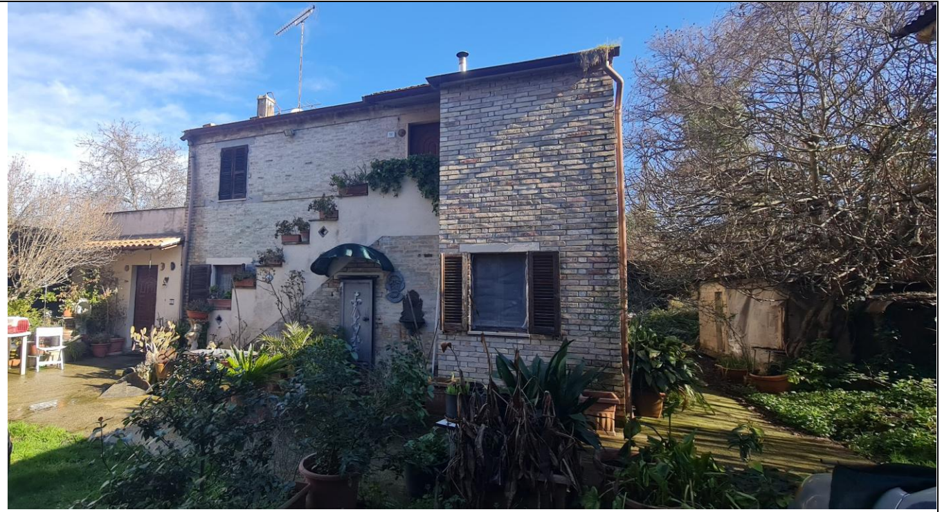
EDIFICIO DA CIELO A TERRA - IMMOBILE 3 – CIVILE ABITAZIONE SU DUE LIVELLI
