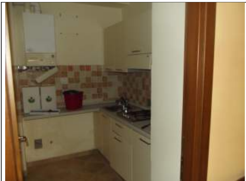
11 – Cucinino di un miniappartamento Fabbricato A
