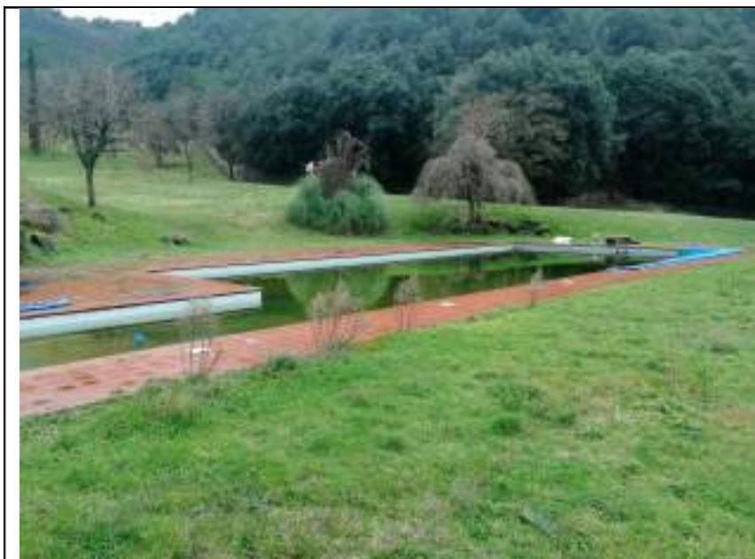
2 – Accessorio piscina posta vicino al fabbricato B
