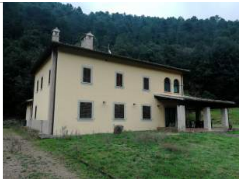
1 – Fabbricato B foglio 160 part. 39 (fabbricato destinato ad agriturismo)
